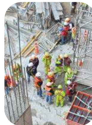
INTERVENCIÓN EN TERRENO "TALLER DE IZAJE".
