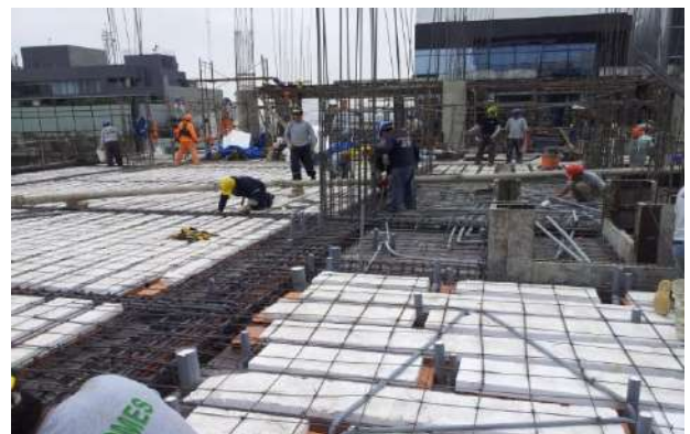
Losas postensadas edificio Eureka - Perú
