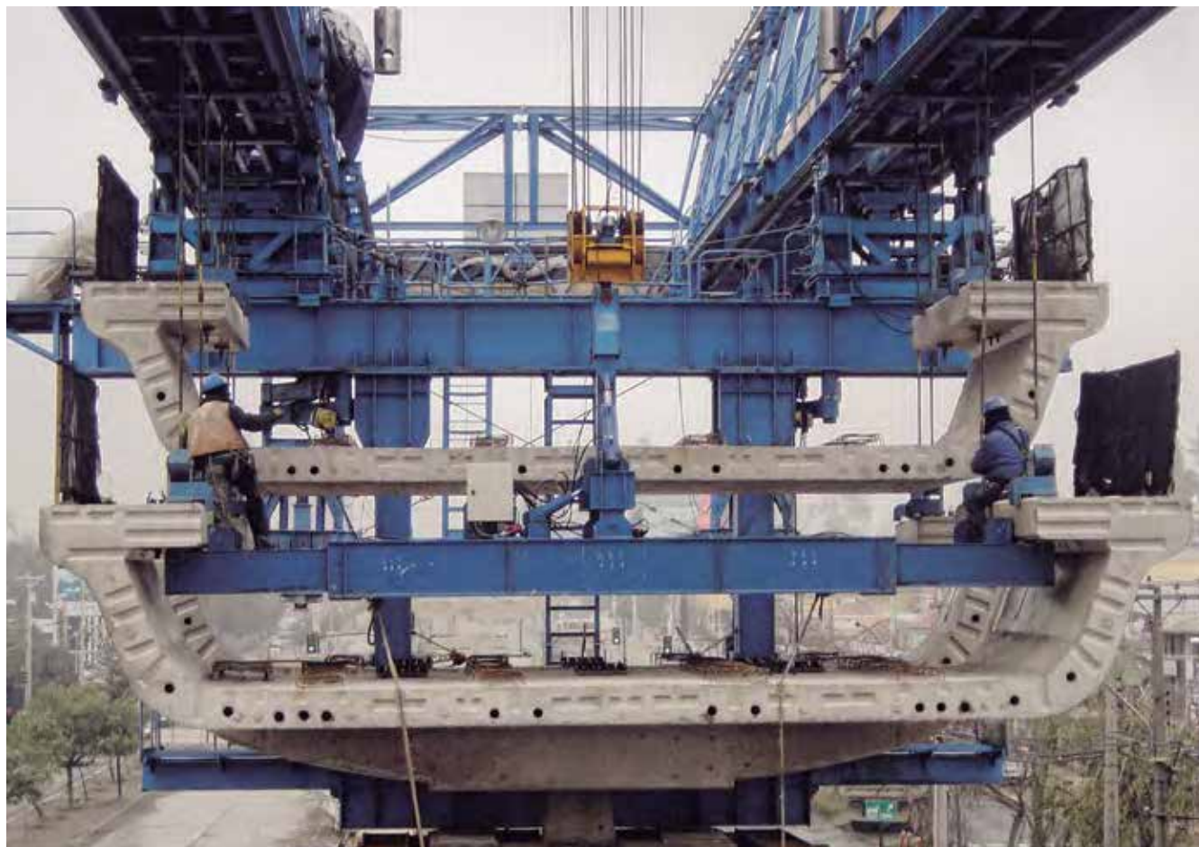
Viaducto Línea 4 Metro de Santiago, Santiago - Chile
