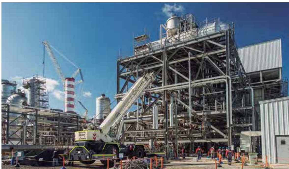
Desarme Tren N°2 Planta Methanex, Punta Arenas - Chile
