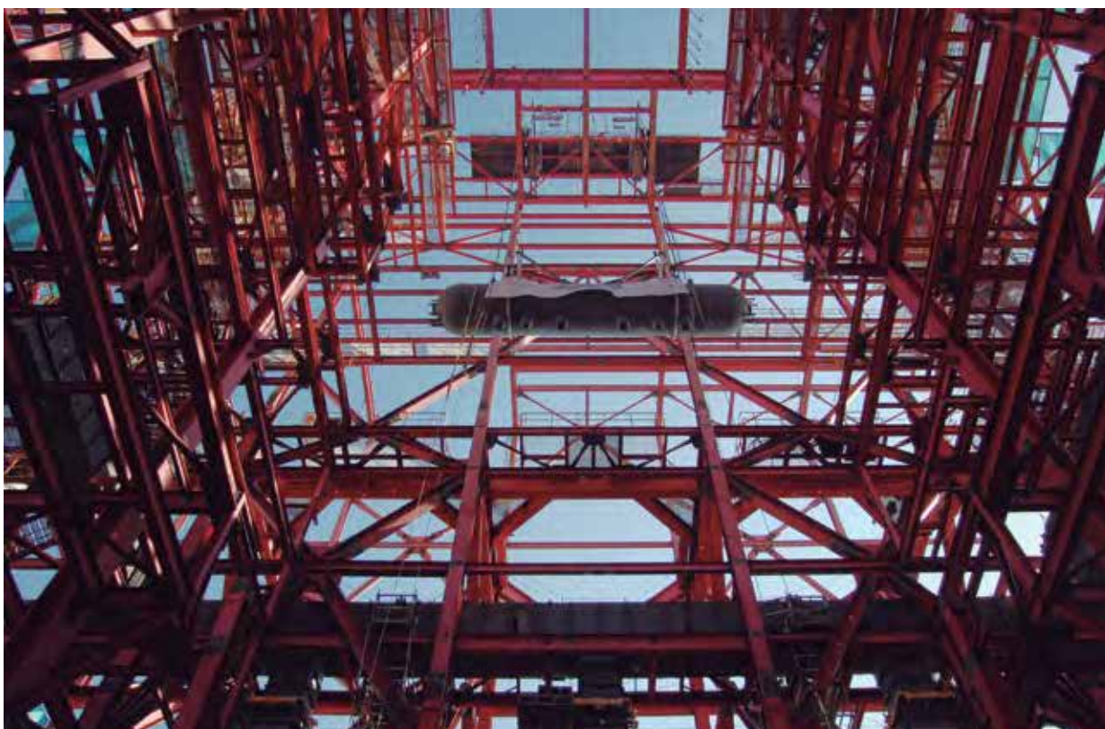
Izaje Domo Central Termoeléctrica Campiche, Ventanas - Chile
