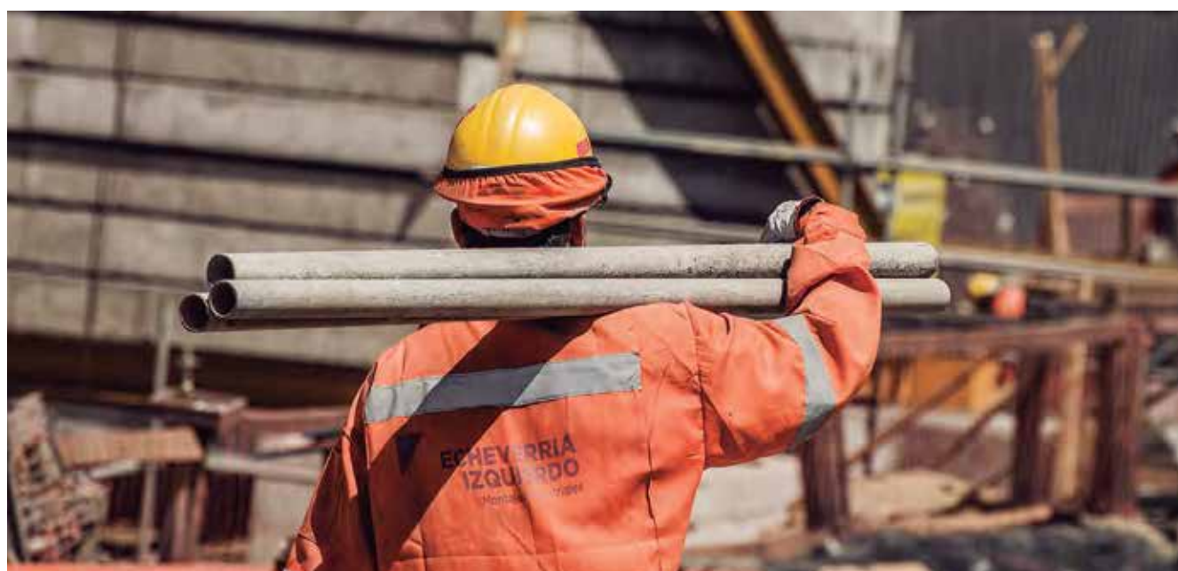
Colaborador proyecto Planta Pellets Minera del Pacífico, Huasco - Chile
