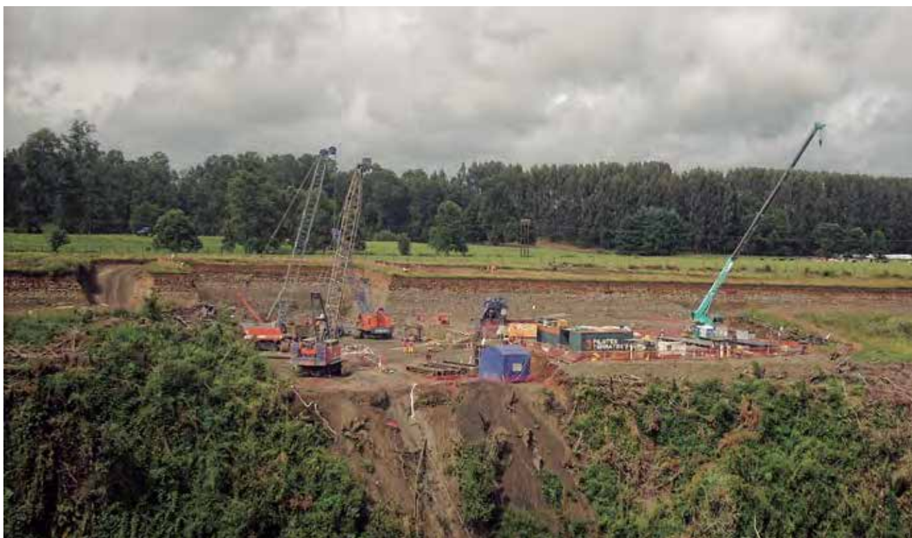
Muro Pantalla Central Hidroeléctrica Rucatayo, Puyehue - Chile
