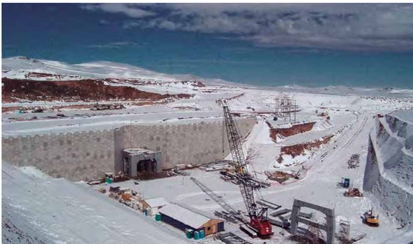
Muro Tierra Retenida Minera Collahuasi, Pica - Chile
