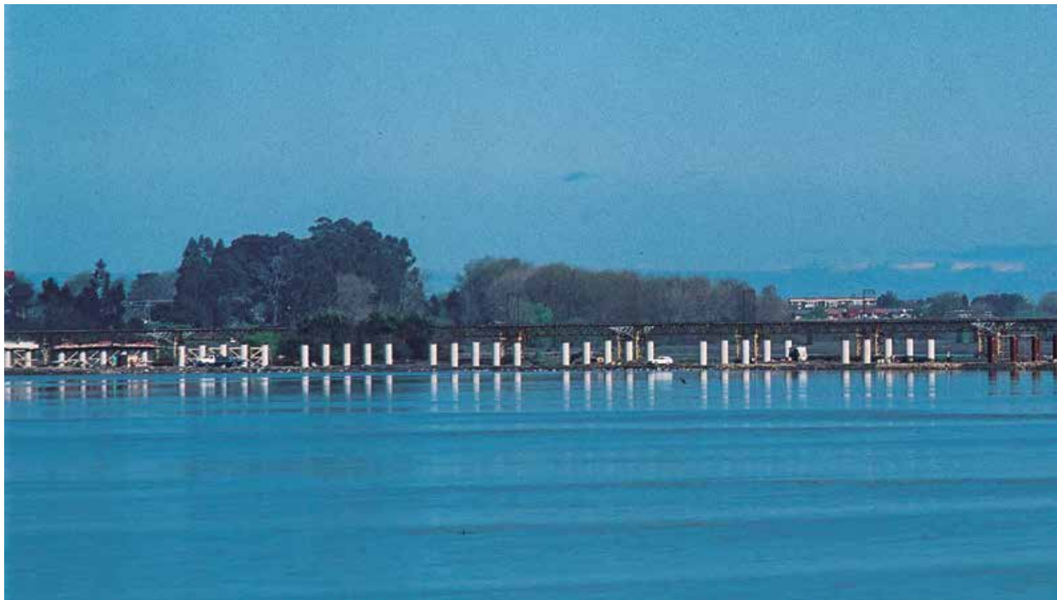
Pilotes pre-excavados Puente Llacolén, sobre río Bío Bío, Concepción y San Pedro de La Paz - Chile
