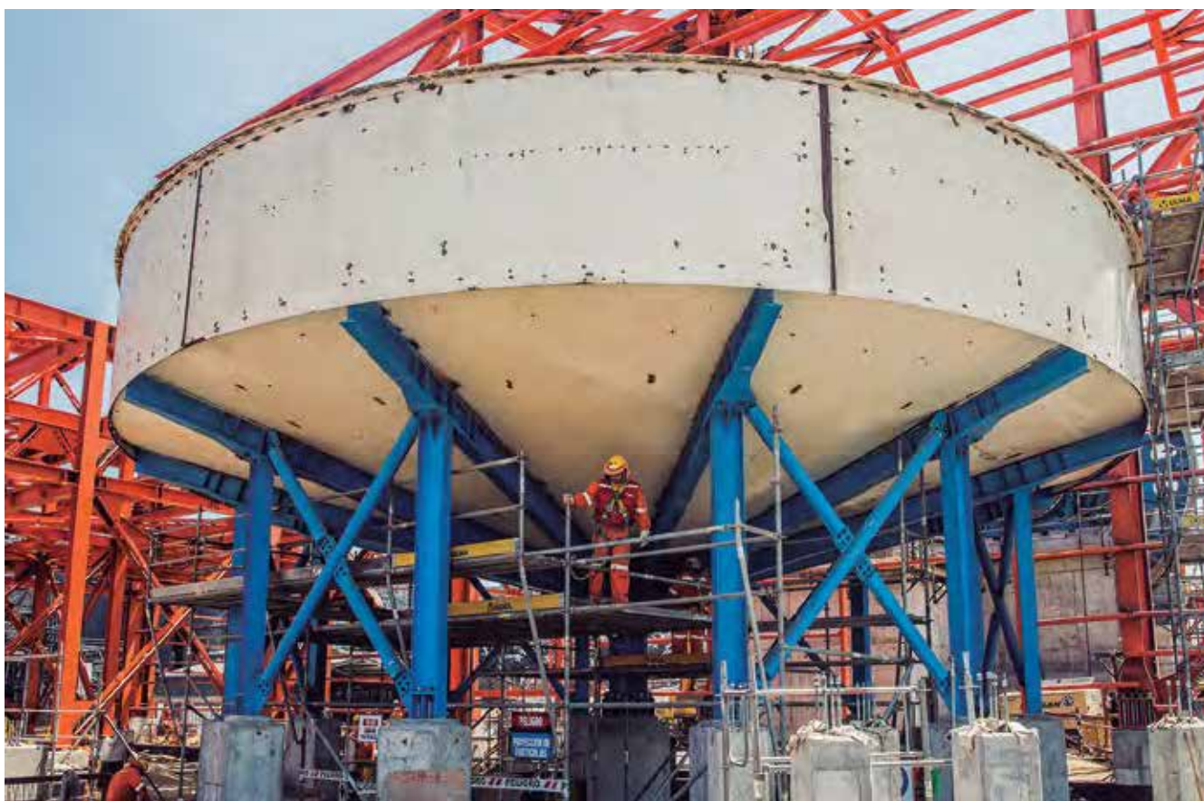
82 Colaborador proyecto Planta Pellets Minera del Pacífico, Huasco - Chile
