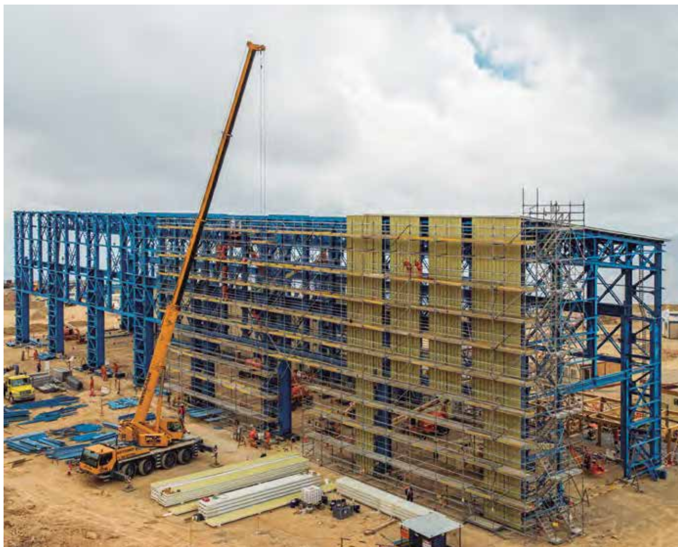
Estructuras y Revestimientos Rajo Sur, Codelco El Teniente, Machalí - Chile
