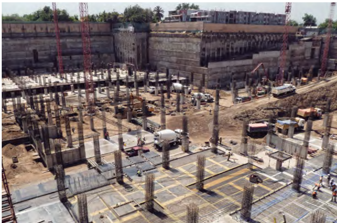
Losa Postensada Mall Plaza Egaña, Santiago - Chile
