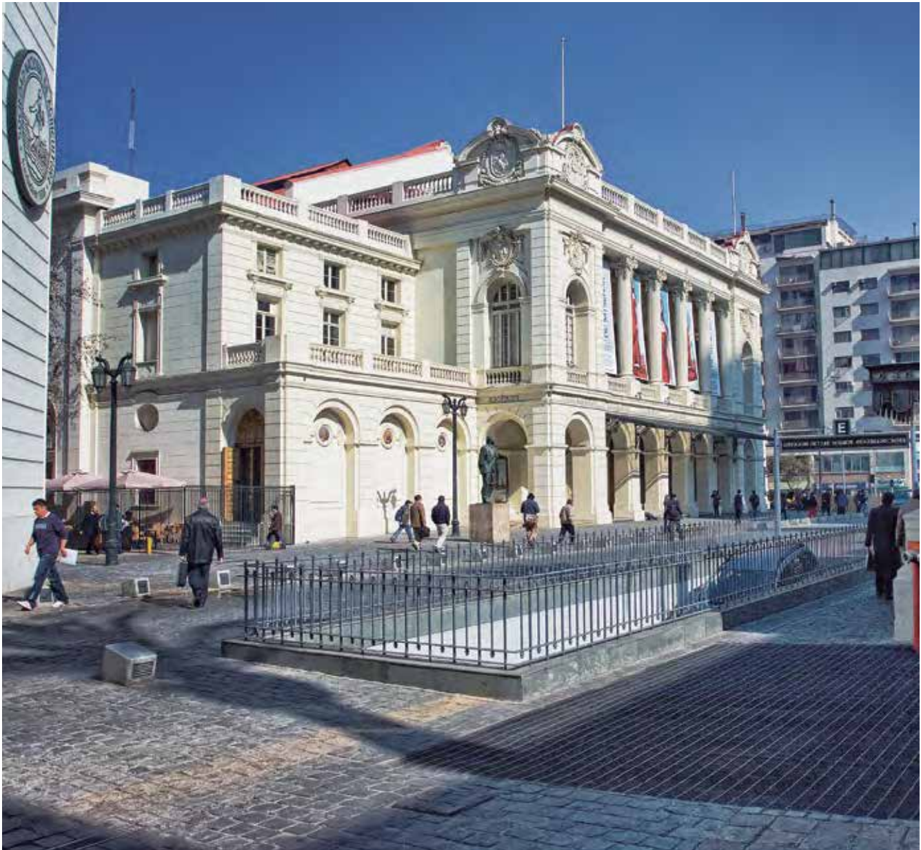
Estacionamiento Subterráneo Plaza Mekis, Santiago - Chile
