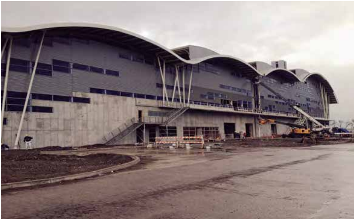
Ampliación Planta Llay Llay Cristalerías Chile, Llay Llay - Chile
