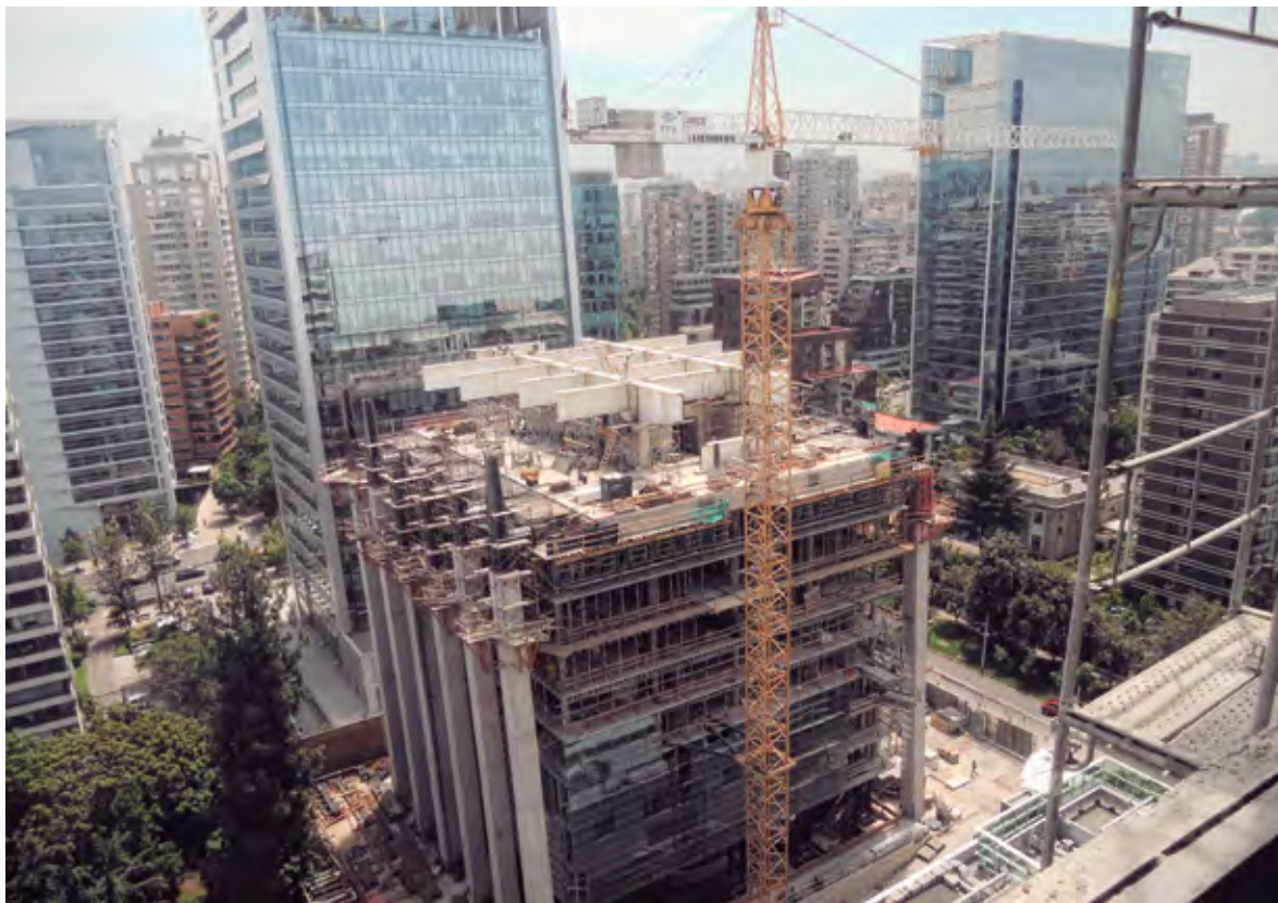
Losa Postensada y Columnas Postensadas Edificio Alcántara 99, Santiago - Chile
