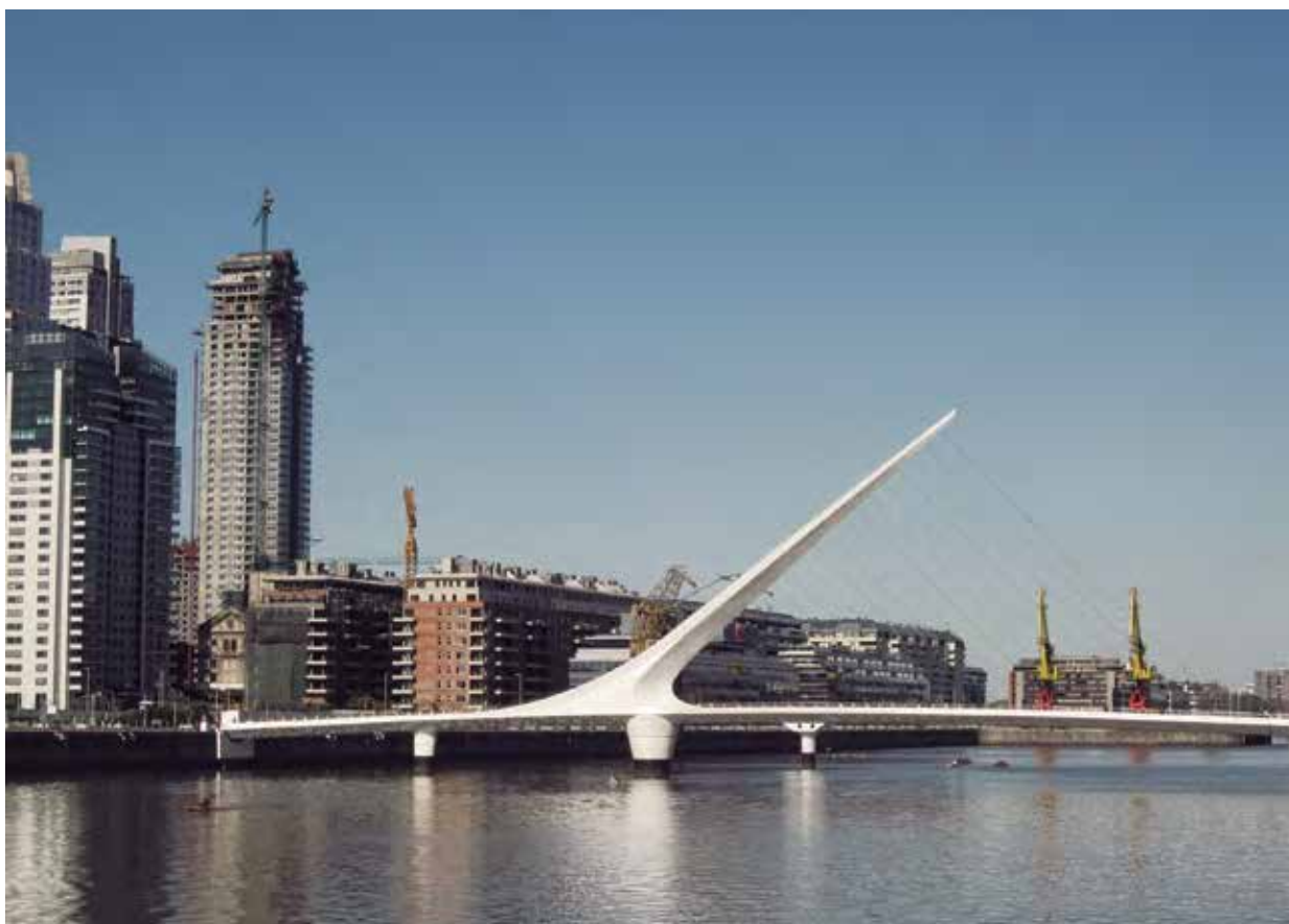
Tirantes Postensados Puente de la Mujer, Buenos Aires - Argentina
