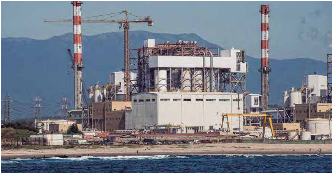
Central Termoeléctrica Campiche Aes Gener, Ventanas - Chile
