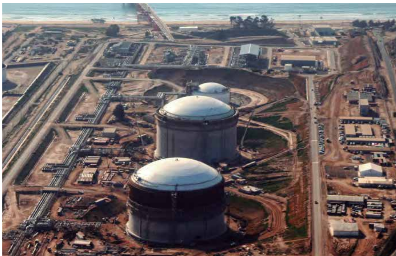
OOCC Estanques GNL Quintero, Quintero - Chile
