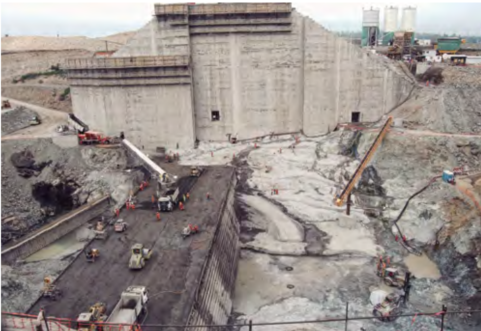
Inyecciones y Drenes Central Hidroeléctrica Angostura, Santa Bárbara y Quilaco - Chile
