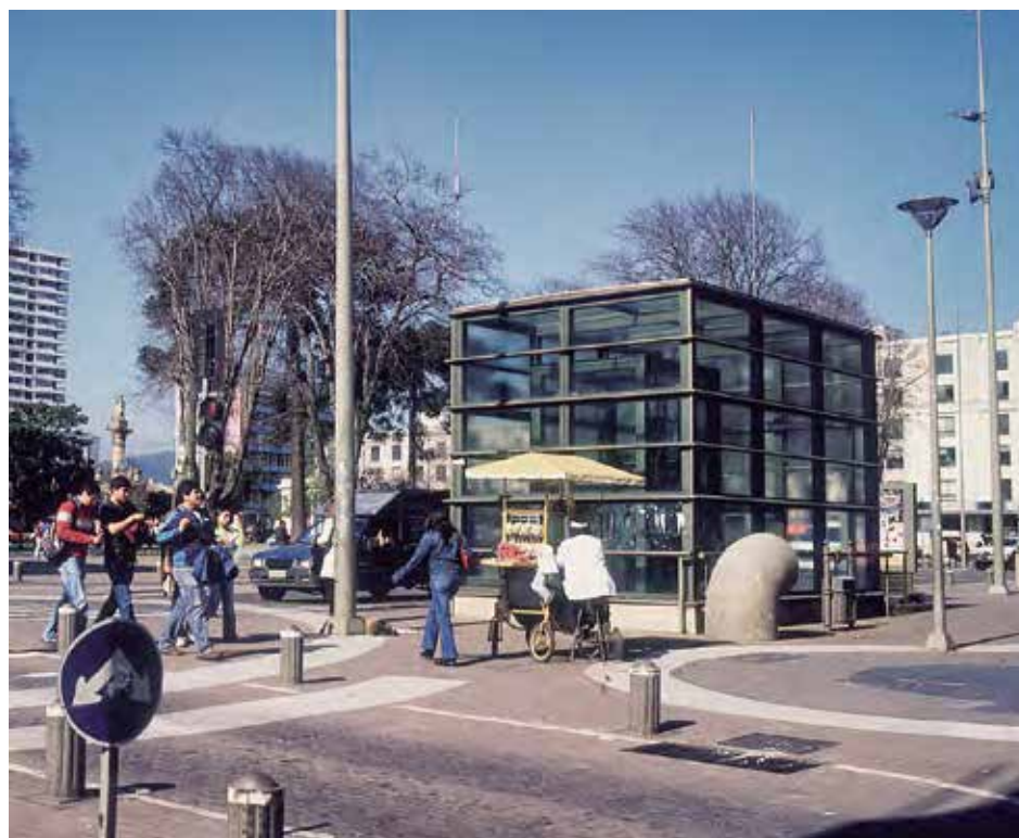
Estacionamiento Subterráneo Plaza de Armas de Concepción, Concepción - Chile
