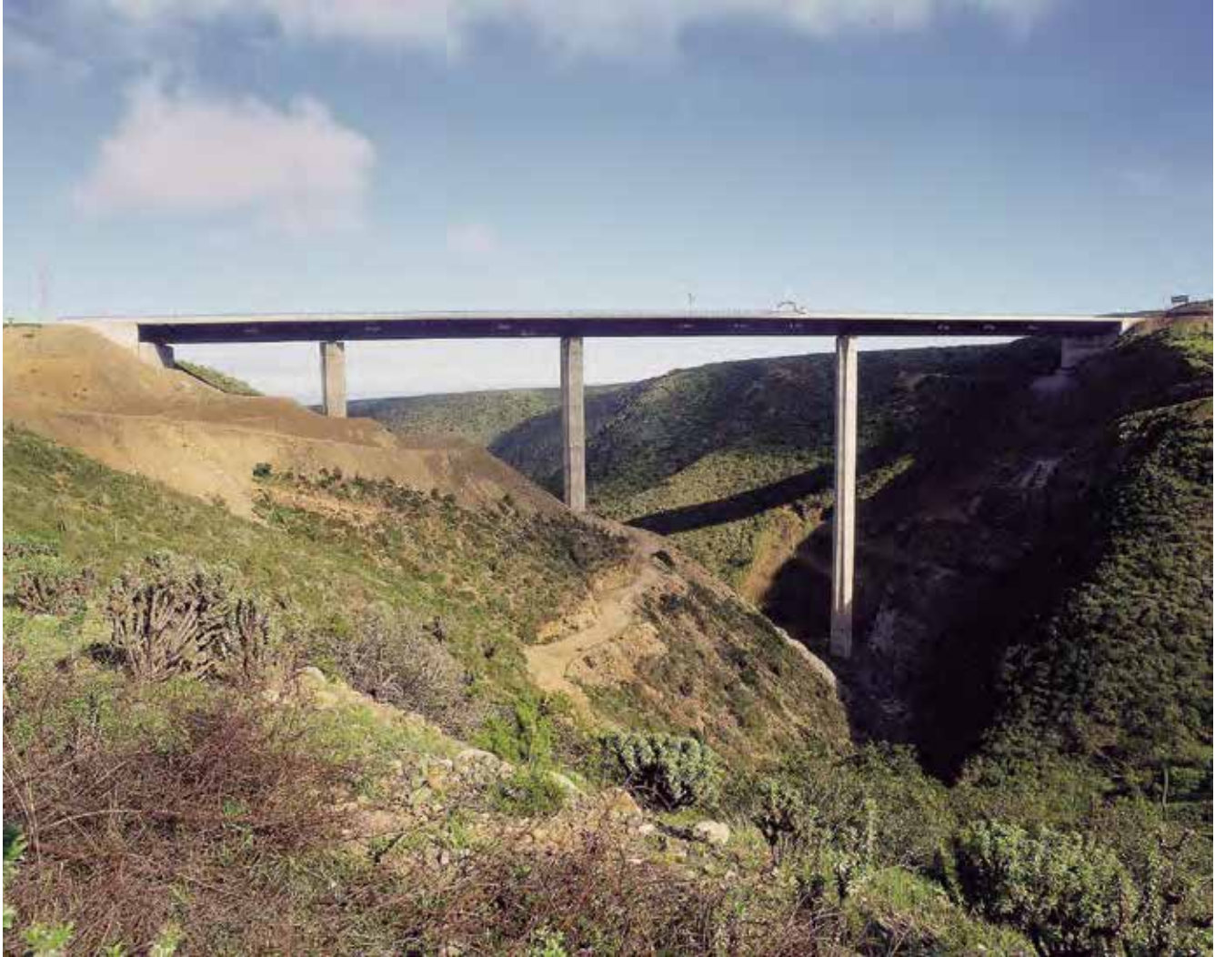
Empujado y Postensado Losa Puente Amolanas, Canela - Chile
