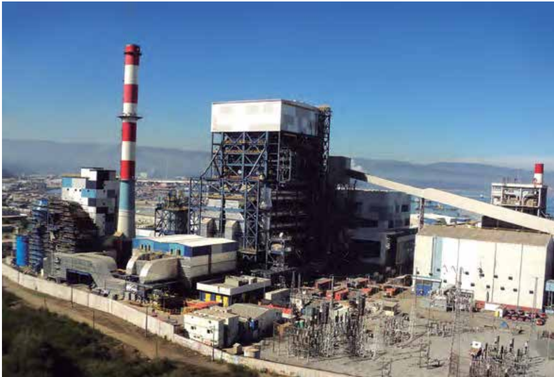
Central Termoelectrica Bocamina II Endesa, Coronel - Chile
