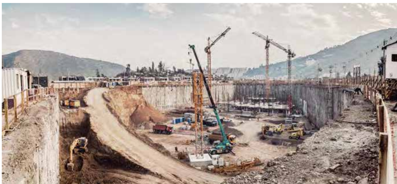
Pilotes de Gran Diametro y Anclajes Postensados Centro Comercial Los Trapenses, Santiago - Chile
