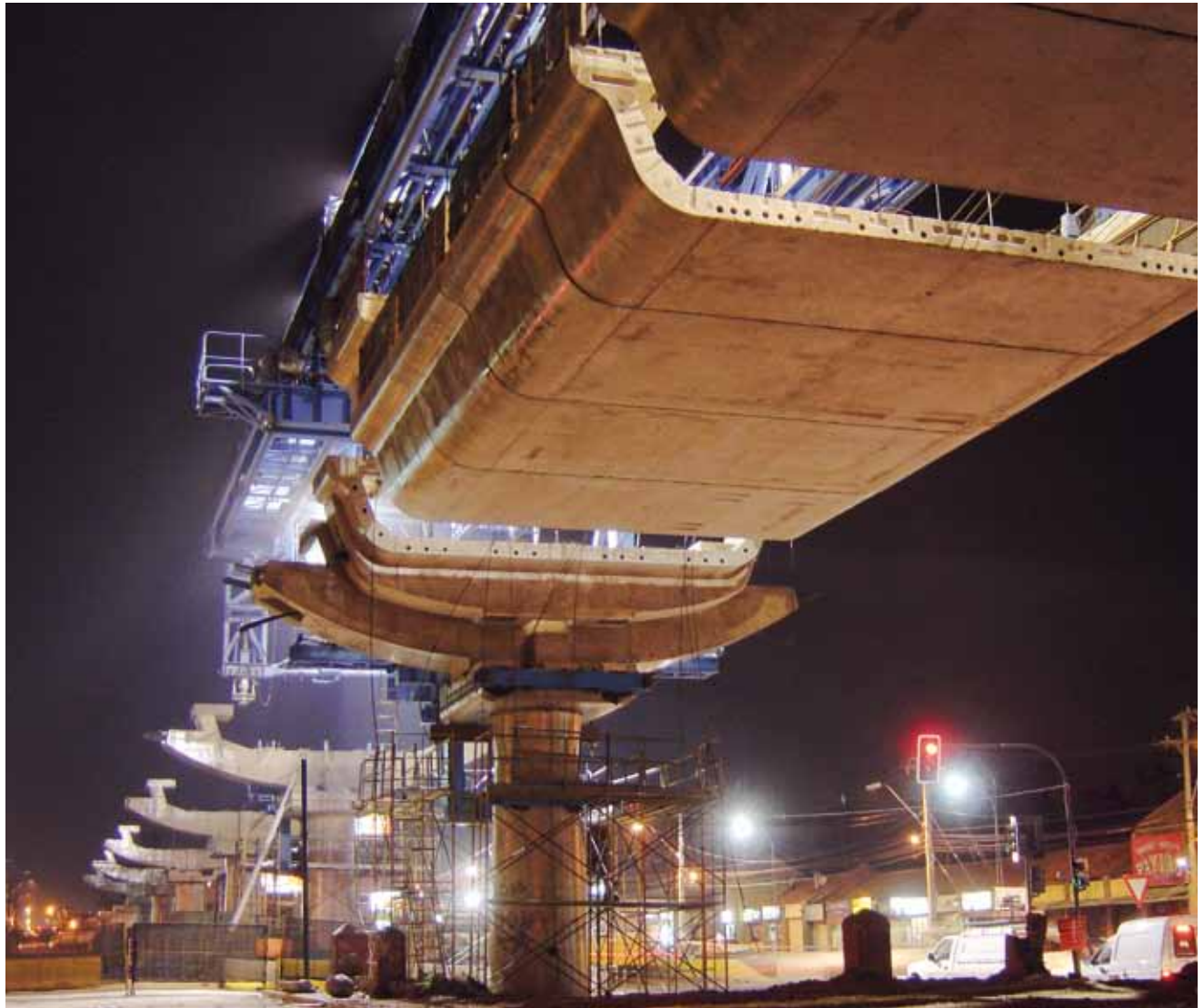
Viaducto Línea 4 Metro, Metro de Santiago, Santiago - Chile
