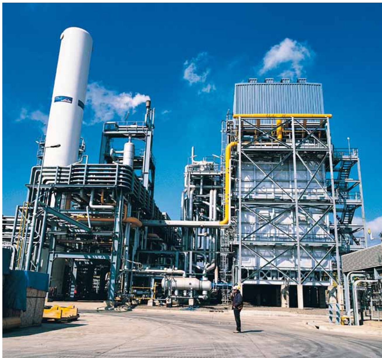
Montaje Estructural Mecánico Planta Hidrógeno Aga Linde, Concón - Chile
