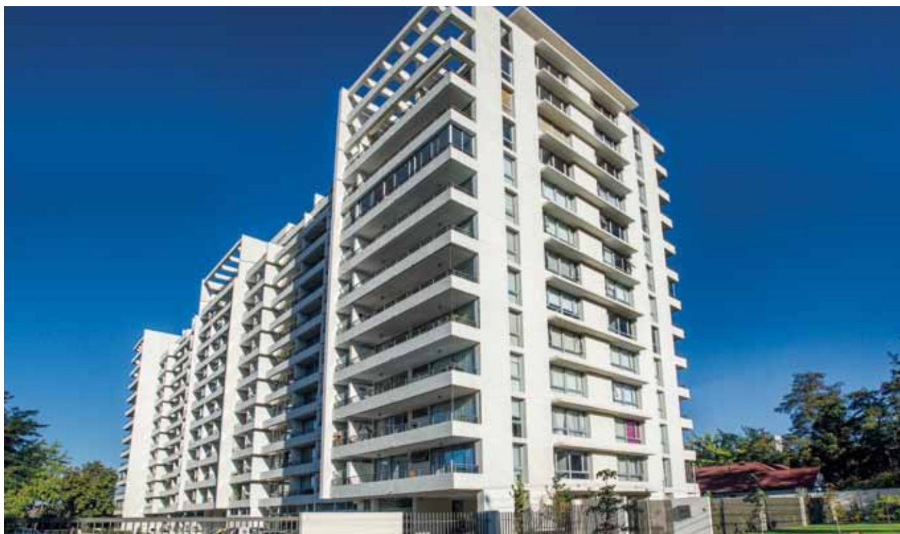
Edificio Ossa Mayor, Santiago - Chile
