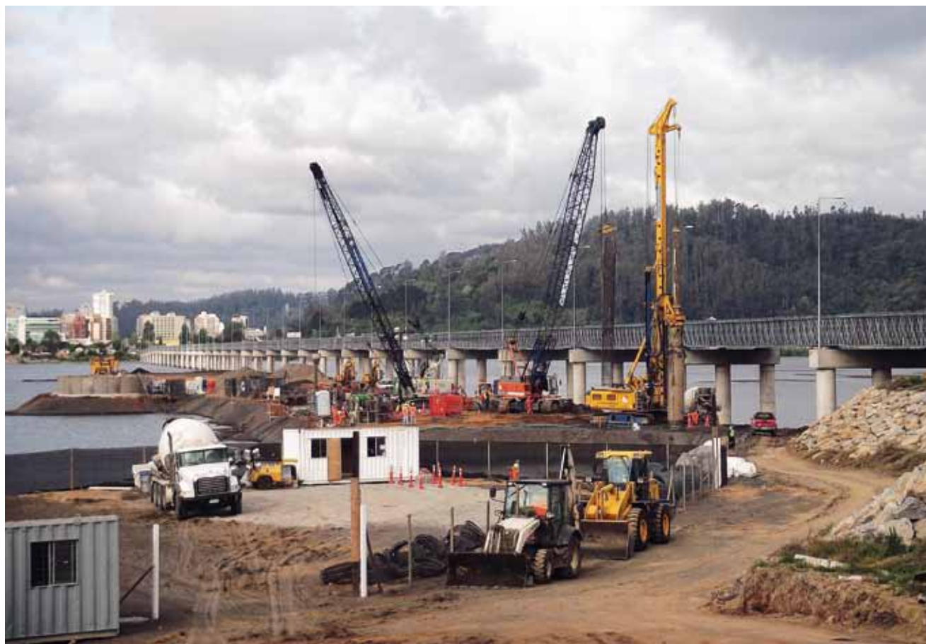
Pilotes Pre-excavados In-Situ, Puente Bicentenario, Concepción - Chile
