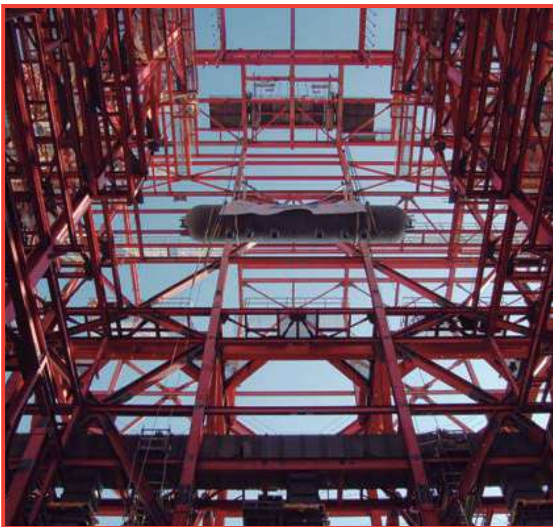
Izaje Domo Central Termoeléctrica Campiche, Ventanas - Chile
