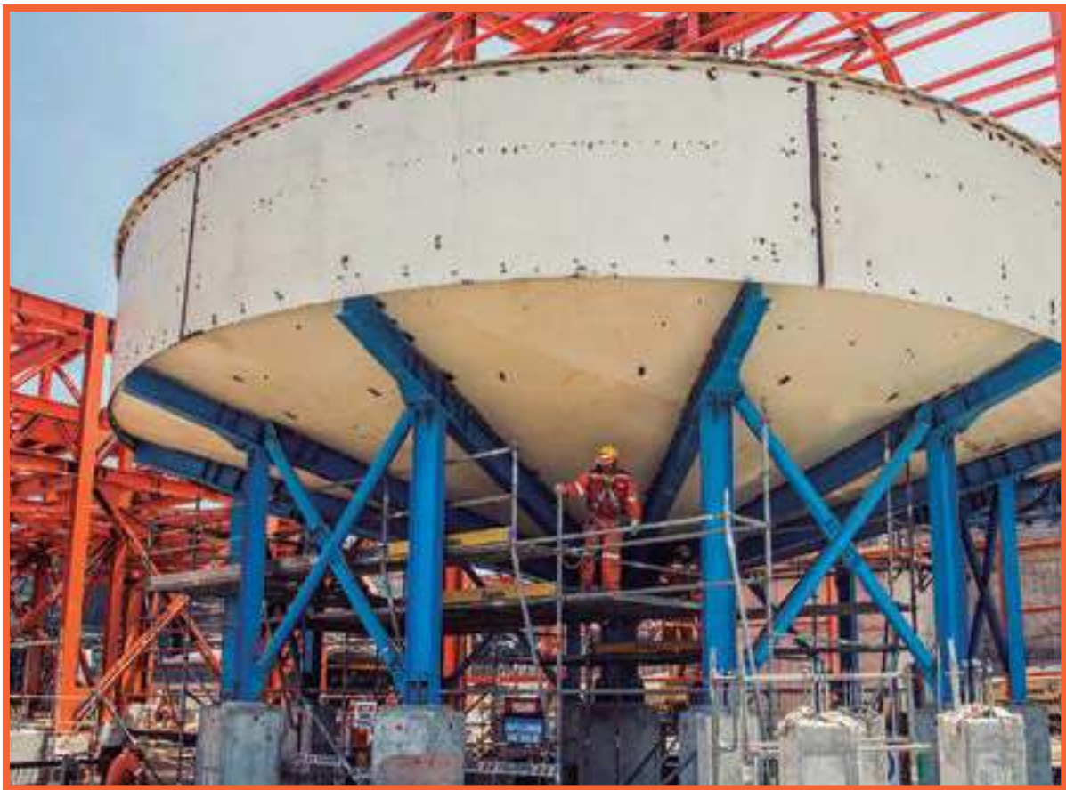
Colaborador proyecto ampliación Planta Pellets, Huasco - Chile
