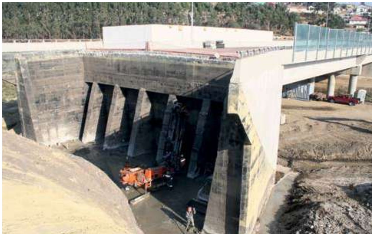
Microplotes, puente Llo-Lleo - Chile
