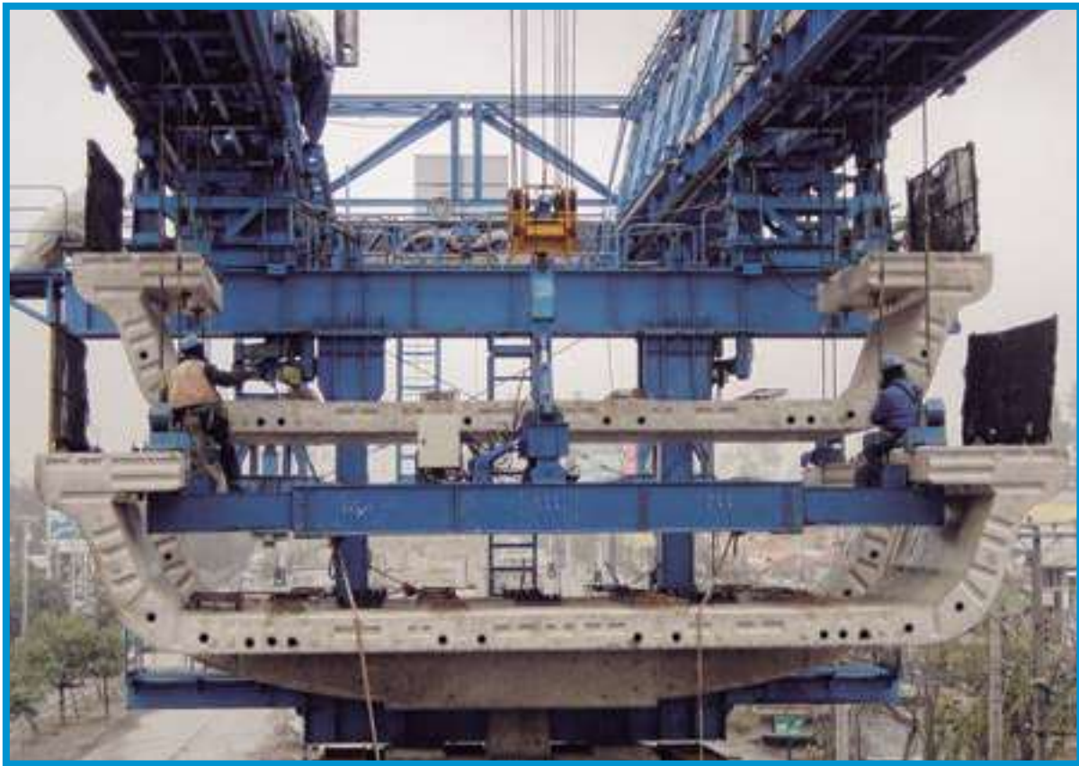
Viaducto Línea 4 Metro de Santiago, Santiago - Chile
