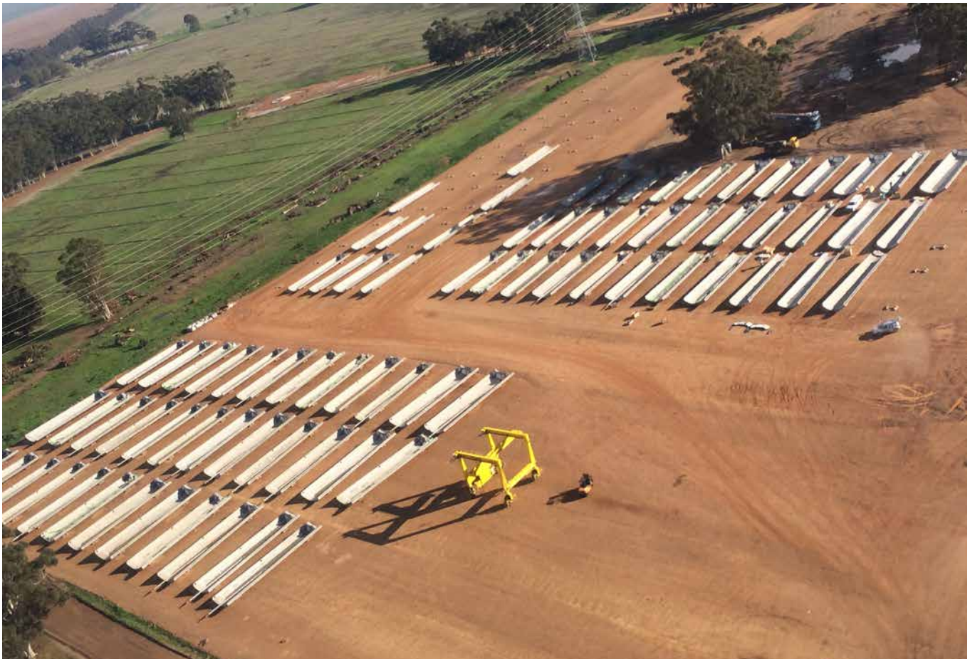
PREFABRICACIÓN Y SUMINISTRO DE PIEZAS DE HORMIGÓN ARMADO PARA 61 TORRES DE PARQUE EÓLICO SAN GABRIEL, COMUNA DE RENAICO – CHILE
