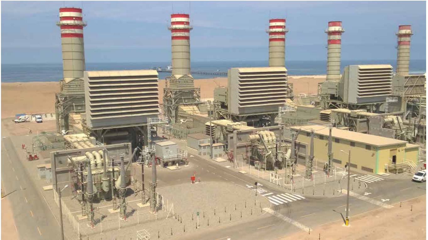
MONTAJE ELECTROMECÁNICO Y BOP NODO ENERGÉTICO PLANTA ILO, PROVINCIA DE ILO – PERÚ
