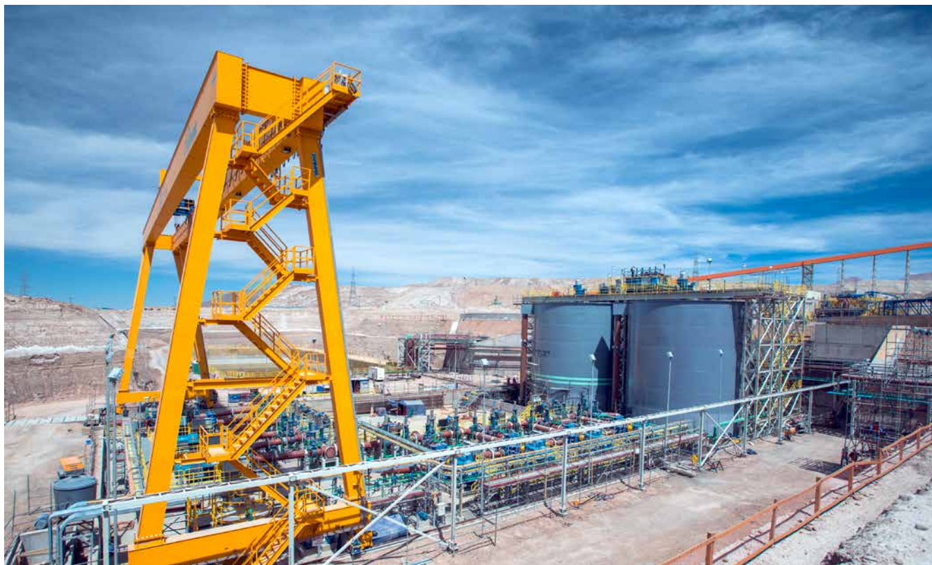
OBRAS CIVILES Y MONTAJE ELECTROMECÁNICO ESPESAMIENTO Y RELAVES MINA MINISTRO HALES, CODELCO, CALAMA – CHILE
