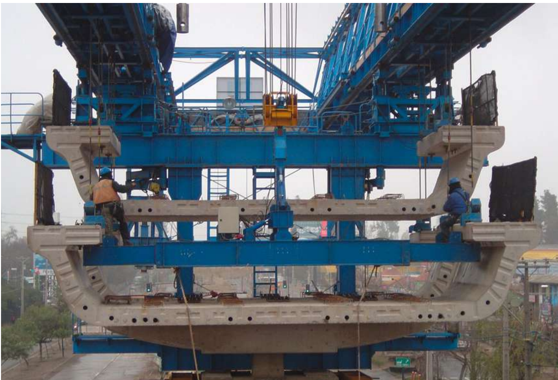
▀ Viaducto Línea 4 Metro de Santiago
