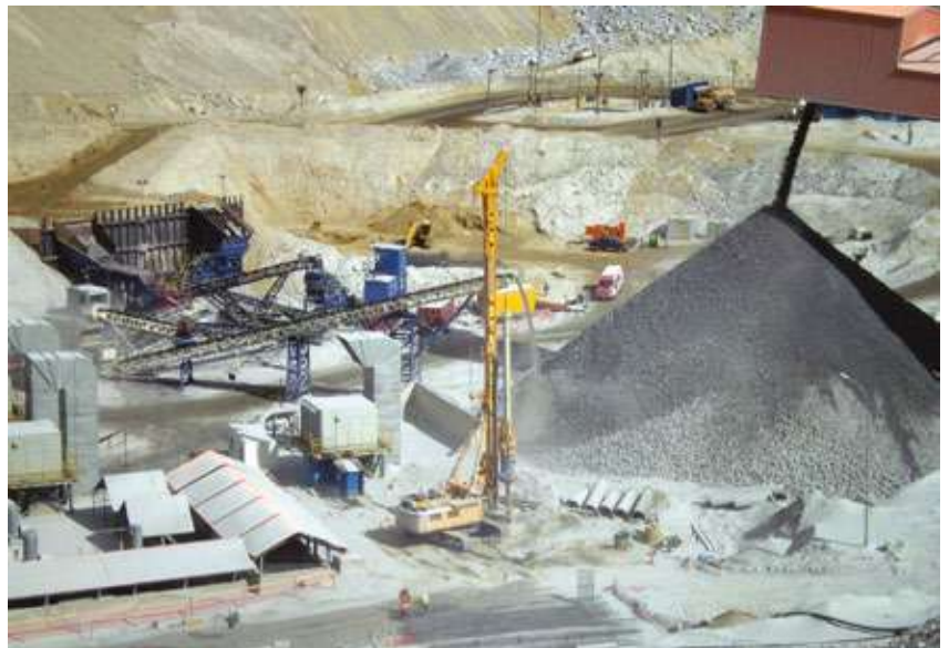
▀ Pilotes pre-excavados Minera Los Pelambres
