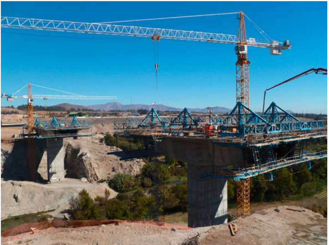
■ Tablero por voladizos sucesivos puente Huasco
