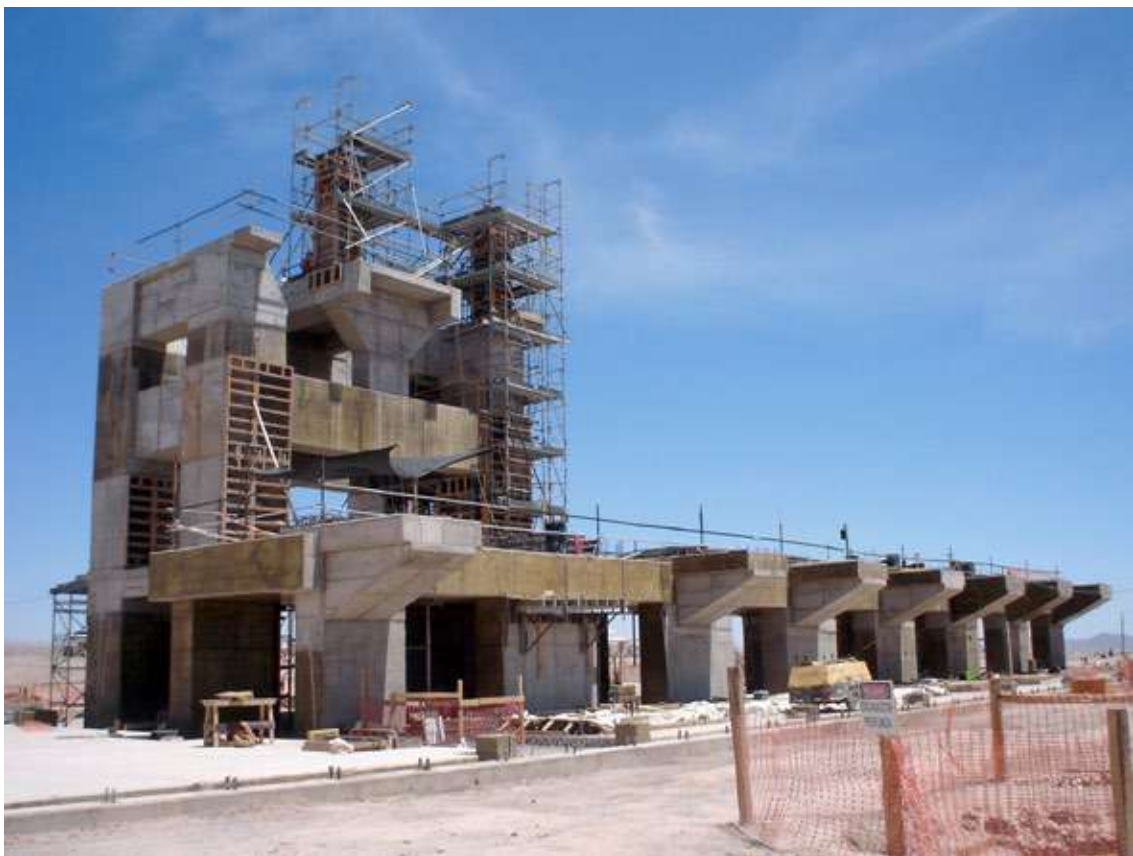
▀ Obras Civiles Minera Spence
