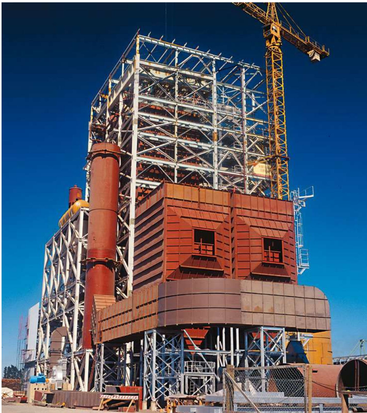
► Planta Cholguan de Paneles Celulosa Arauco
