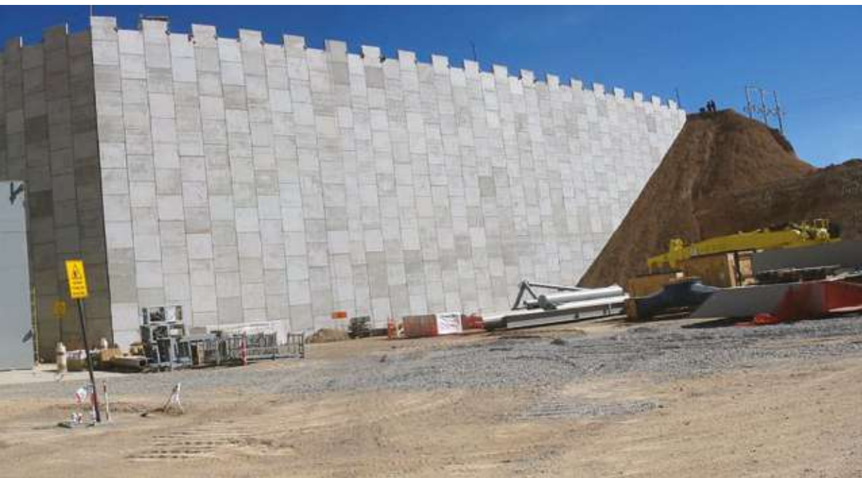
■ Muro de Tierra Retenida Minera Collahuasi
