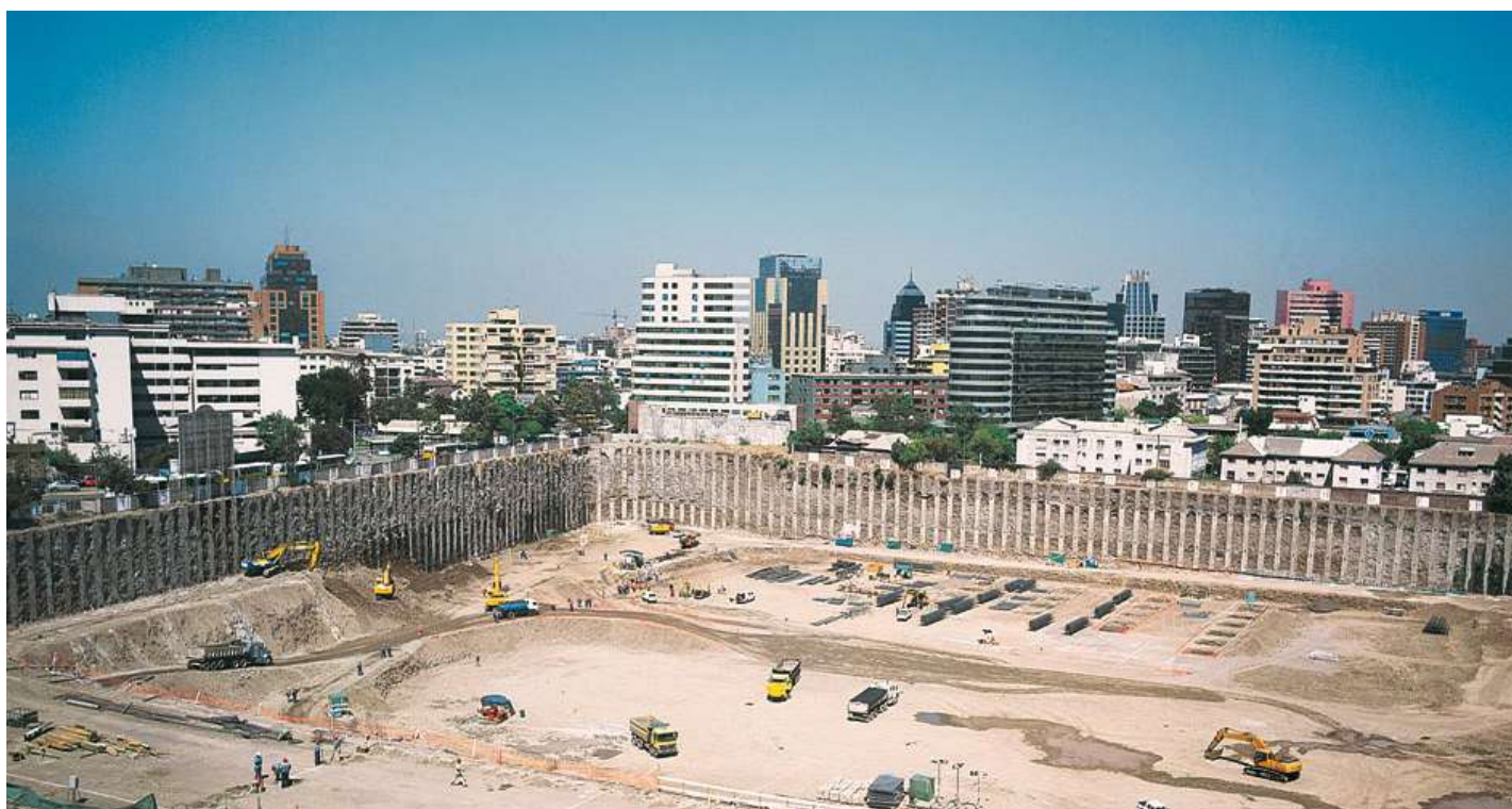
► Anclajes Postensados Mall Costanera Center
