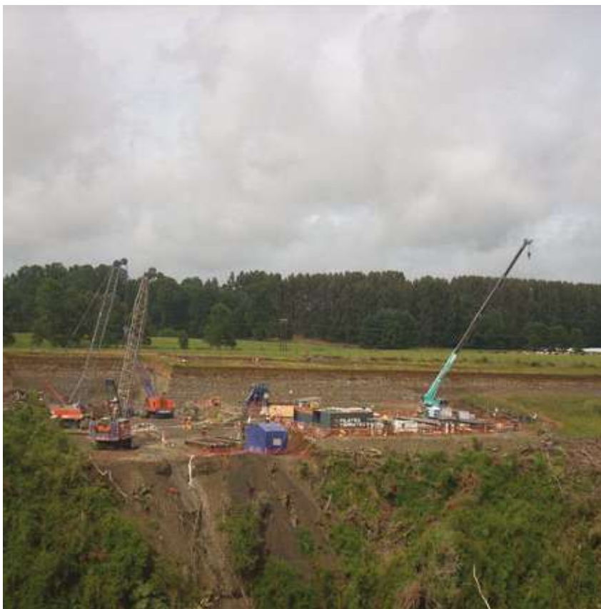
▀ Muro Pantalla Central Hidroeléctrica Rucatayo
