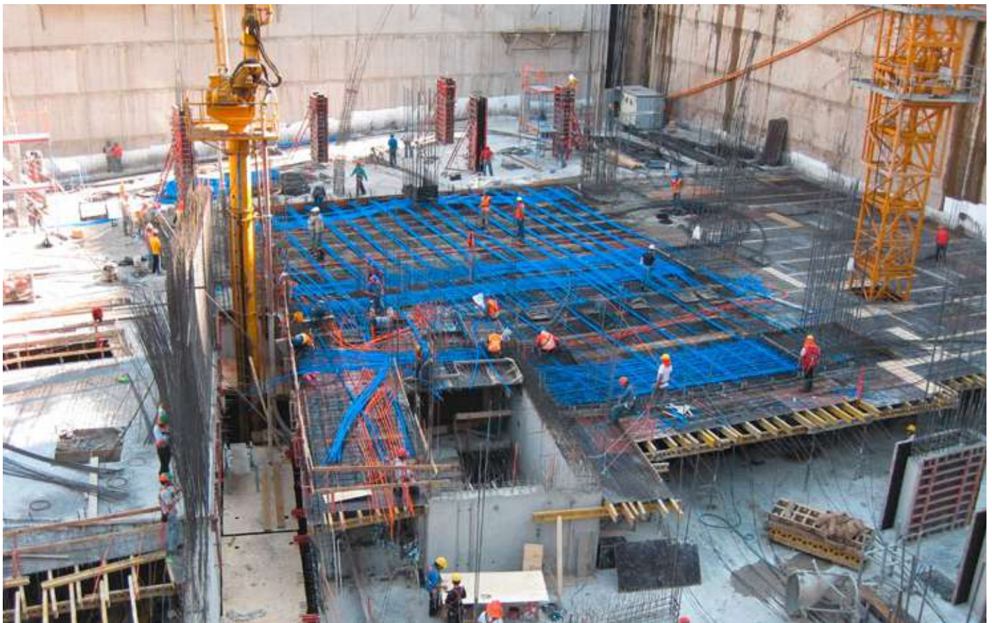
▀ Losa Postensada Edificio de Las Artes
