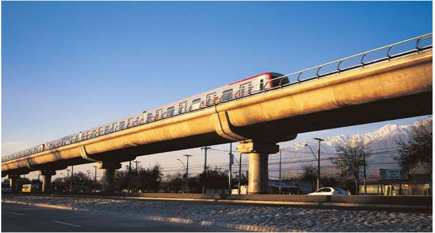
▀ Viaducto Línea 4 Metro Puente Alto
