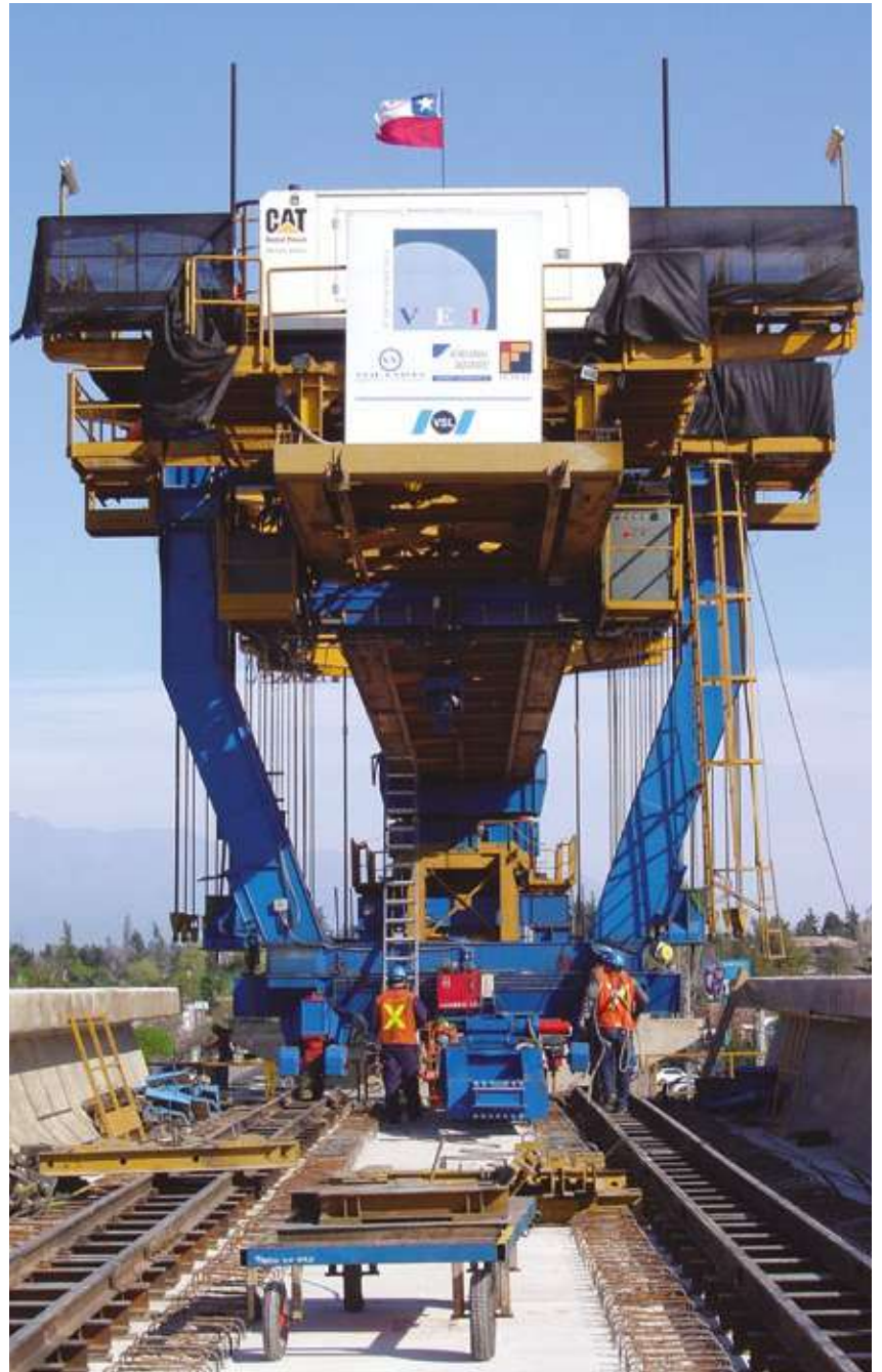
▀ Viaducto línea 4 Metro de Santiago
