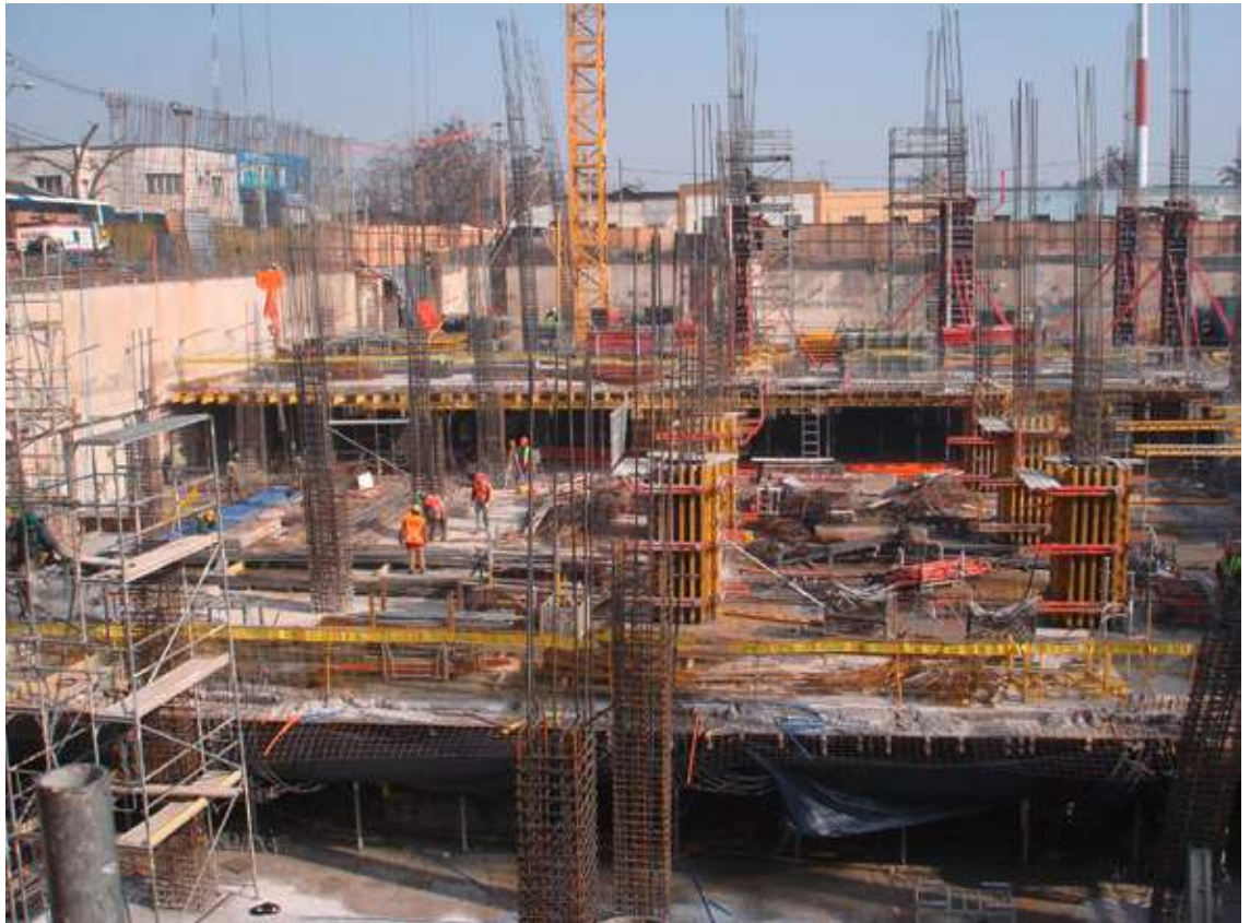
■ Losa Postensada Mall Plaza Alameda
