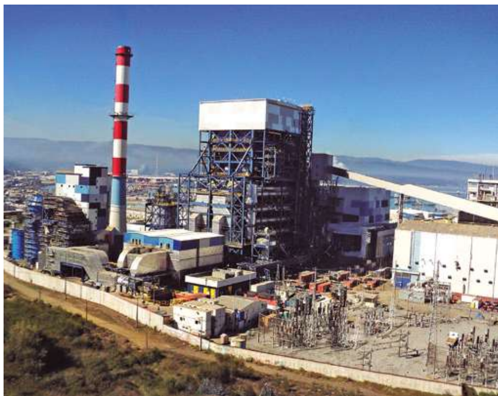
Central Termoeléctrica Bocamina II Endesa
