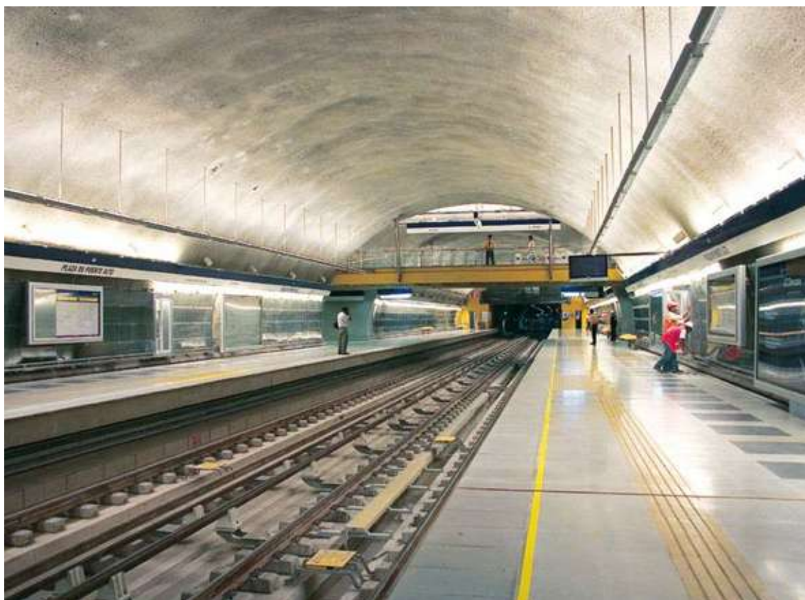
▀ Estación Puente Alto, línea 4 Metro de Santiago
