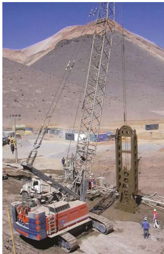
▀ Muro Pantalla Plástica Mina la Coipa
