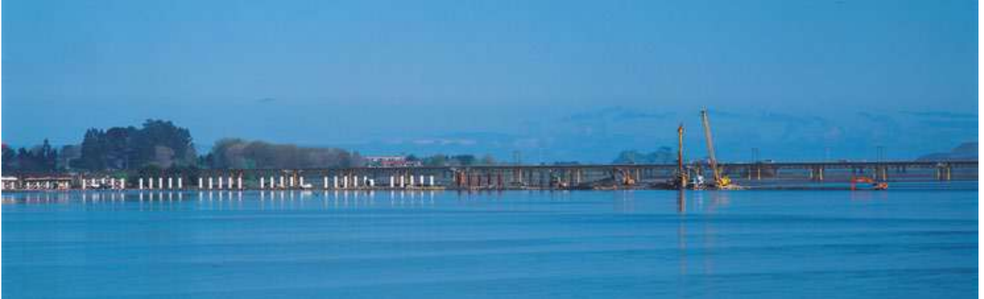
▀ Pilotes pre-excavados Puente Llacolén; BíoBío Concepción
