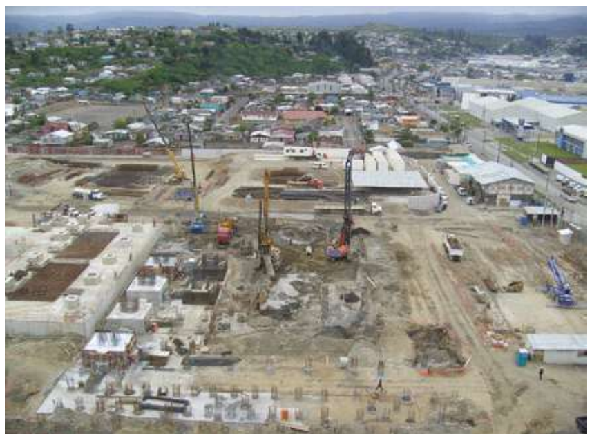
▀ Pilotes pre-excavados Central Termoeléctrica Bocamina II
