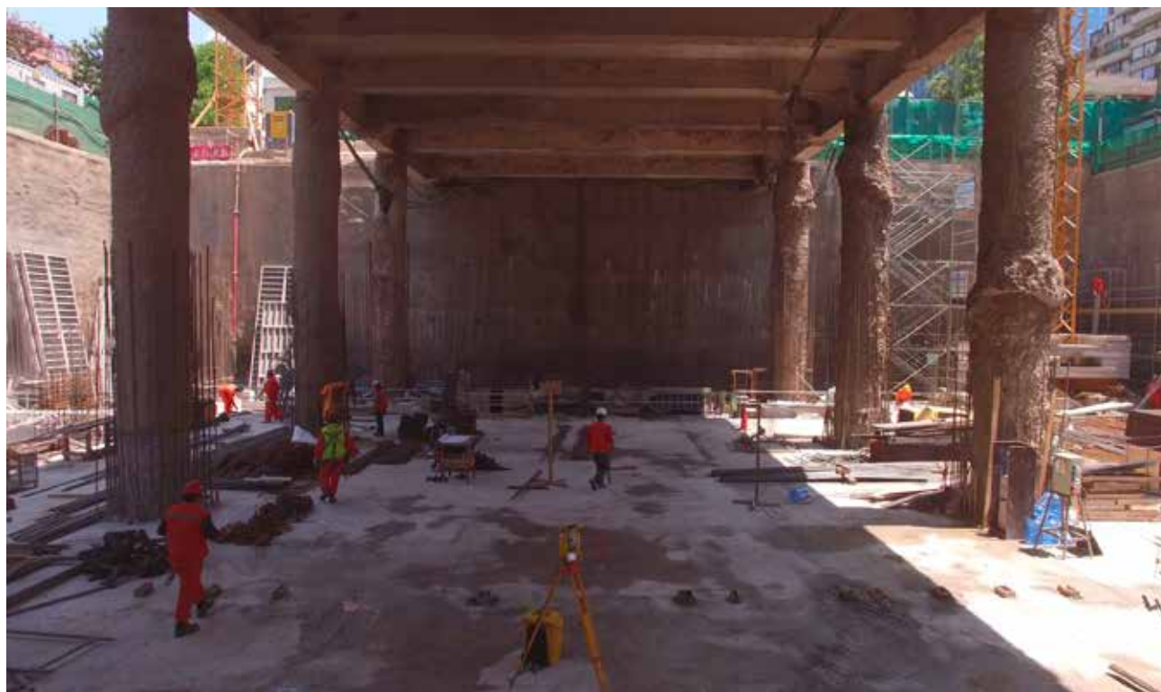
OBRAS CIVILES ESTACIÓN LOS LEONES LÍNEA 6 DEL METRO DE SANTIAGO – CHILE
