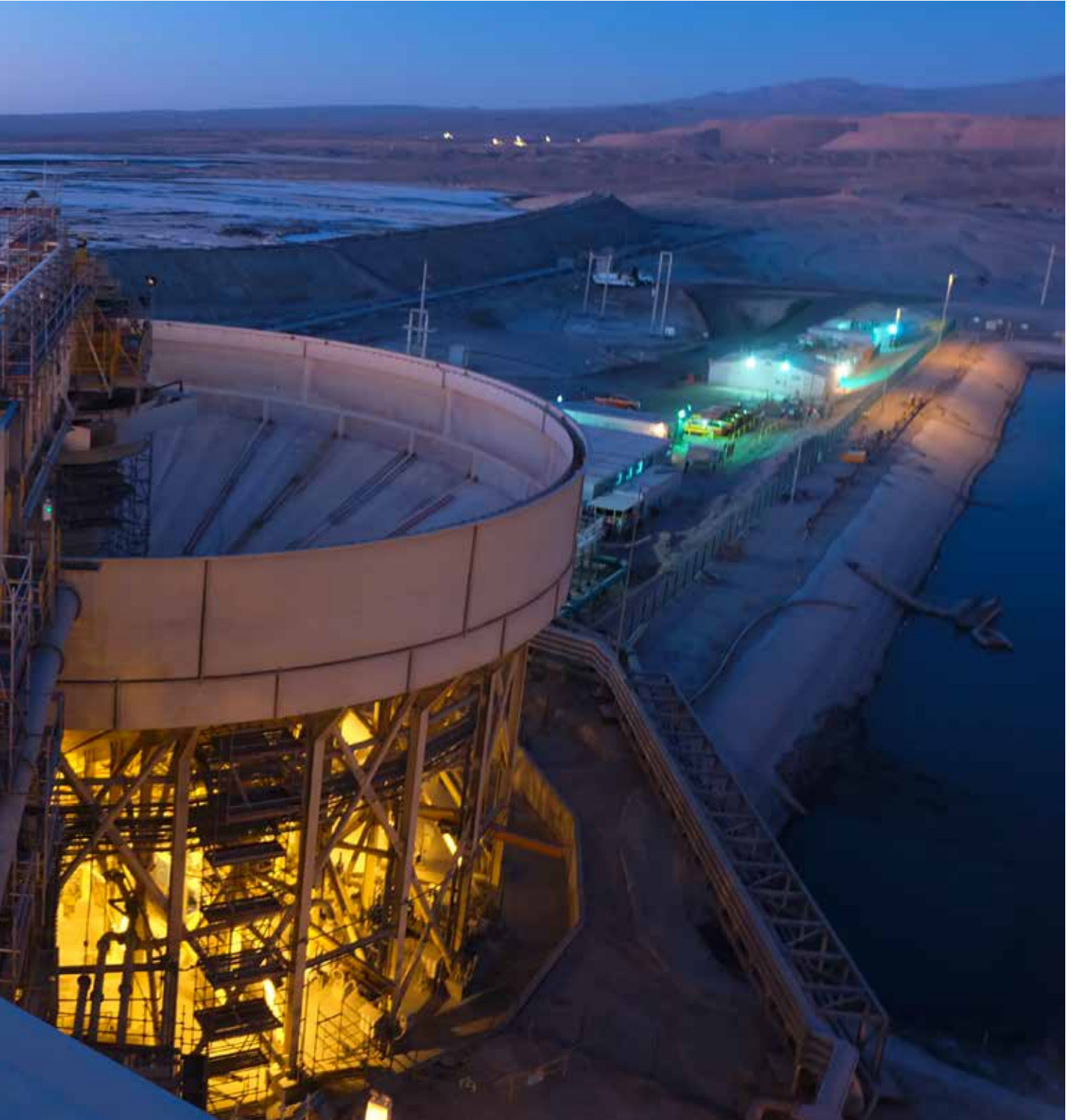
MONTAJE ELECTROMECÁNICO ESPESADORES DE PASTA, MINERA CENTINELA, CALAMA – CHILE
