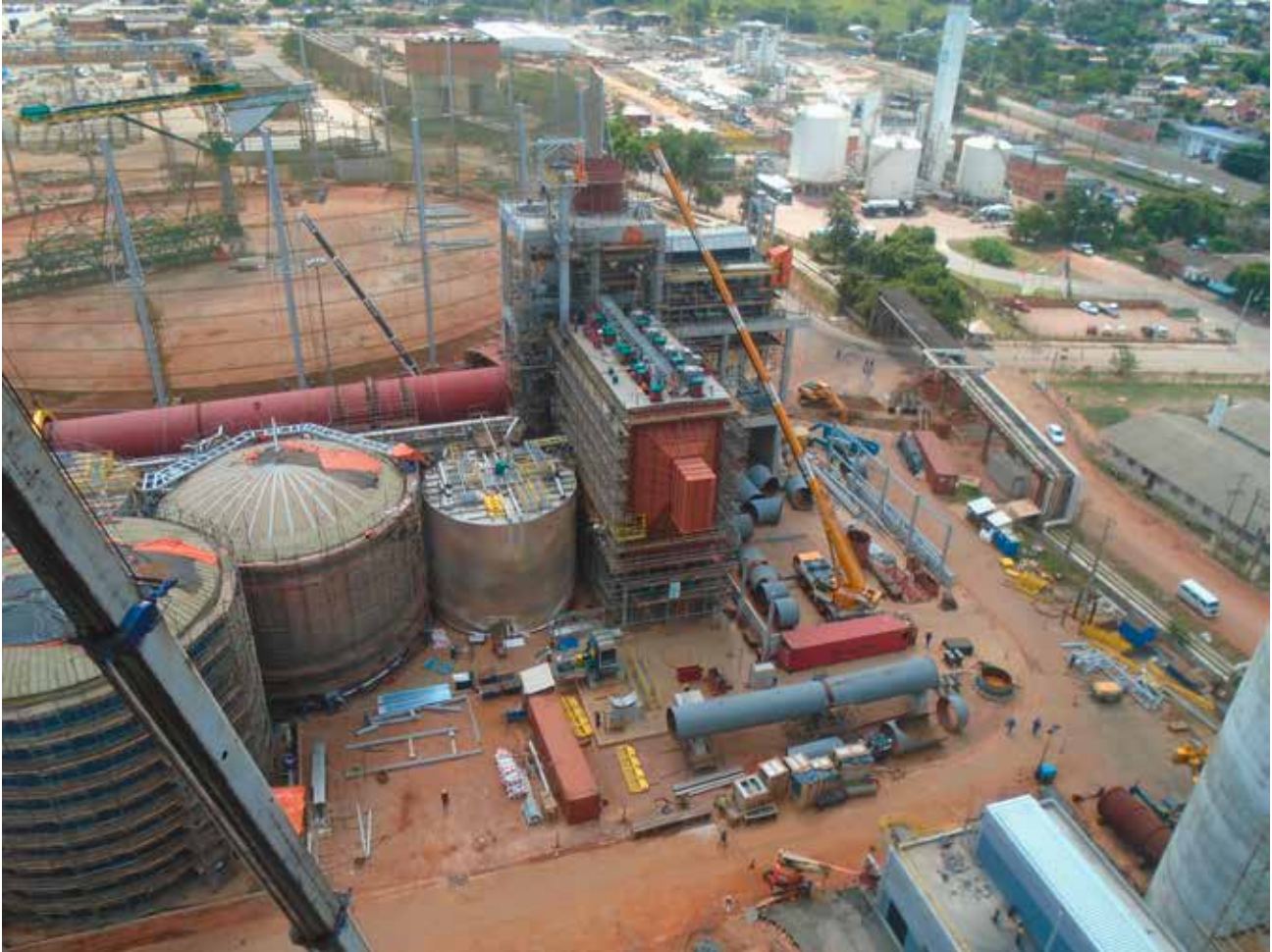
MONTAJE ELECTROMECÁNICO DE LA PLANTA DE CAUSTIFICACIÓN Y HORNO DE CAL DE LA CELULOSA CMPC, GUAIBA – BRASIL
