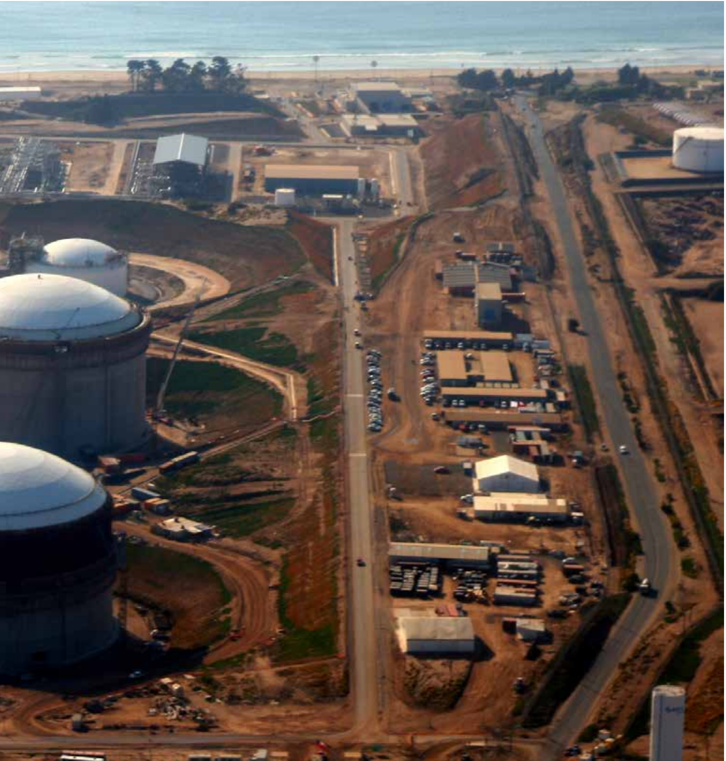
ESTANQUES TERMINAL GNL QUINTERO, QUINTERO – CHILE
