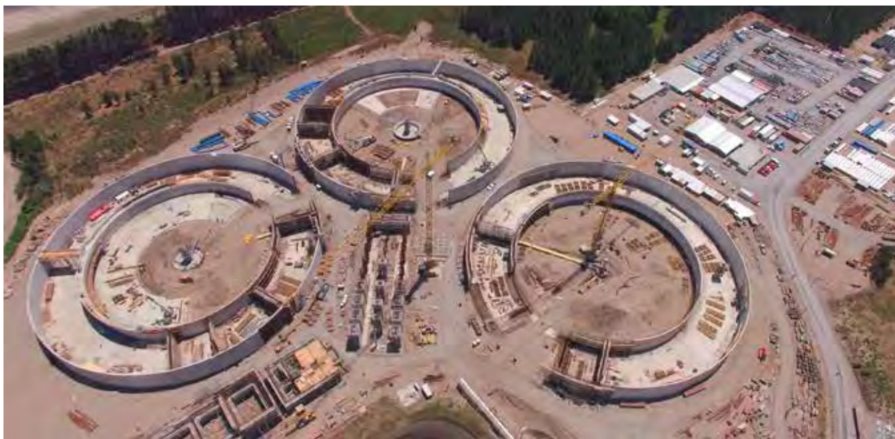
MONTAJE CIVIL ELECTROMECÁNICO PLANTA TRATAMIENTO DE EFLUENTES, PLANTA ARAUCO, CELULOSA ARAUCO Y CONSTITUCIÓN S.A. – CHILE
