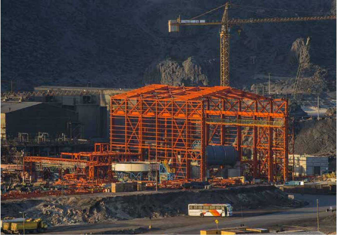
OBRAS CIVILES Y MONTAJE ELECTROMECÁNICO PLANTA PELLETS, HUASCO – CHILE
