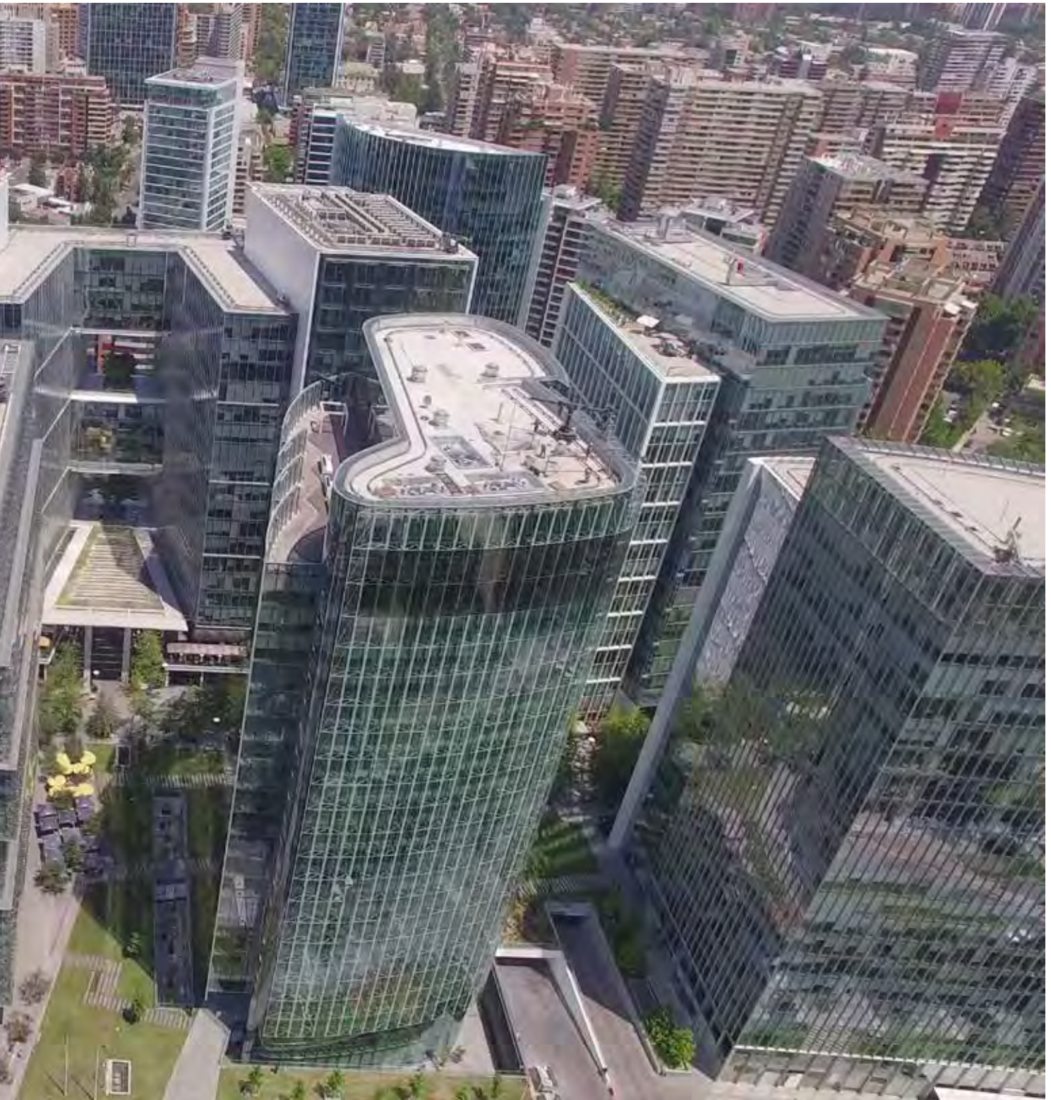
EDIFICIO ARRAU, EDIFICIO MATTÁ, EDIFICIO NUEVA LAS CONDES 7 Y EDIFICIO DE LAS ARTES, SANTIAGO – CHILE
