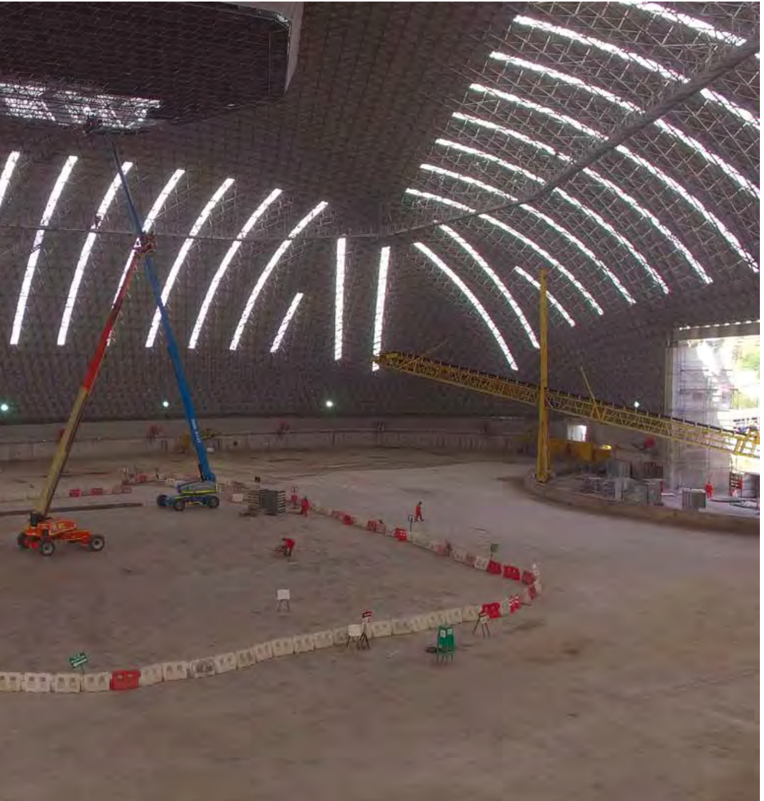
TECHADO CANCHAS DE CARBÓN DE CENTRAL BOCAMINA, ENEL, CORONEL – CHILE
