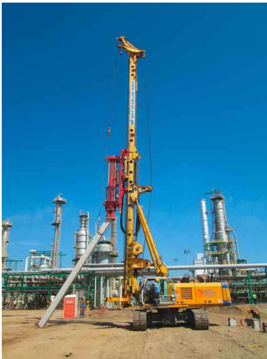
PILOTES REFINERÍA TALARA, TALARA – PERÚ
