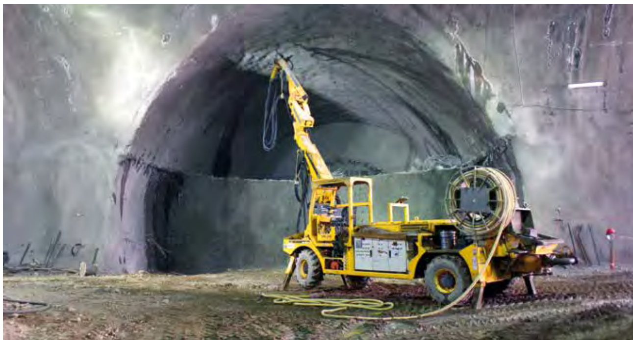
OBRAS CIVILES DE PIQUE, GALERÍA Y TÚNEL DEL ENLACE LÍNEA 6 - LÍNEA 3, METRO DE SANTIAGO - CHILE
