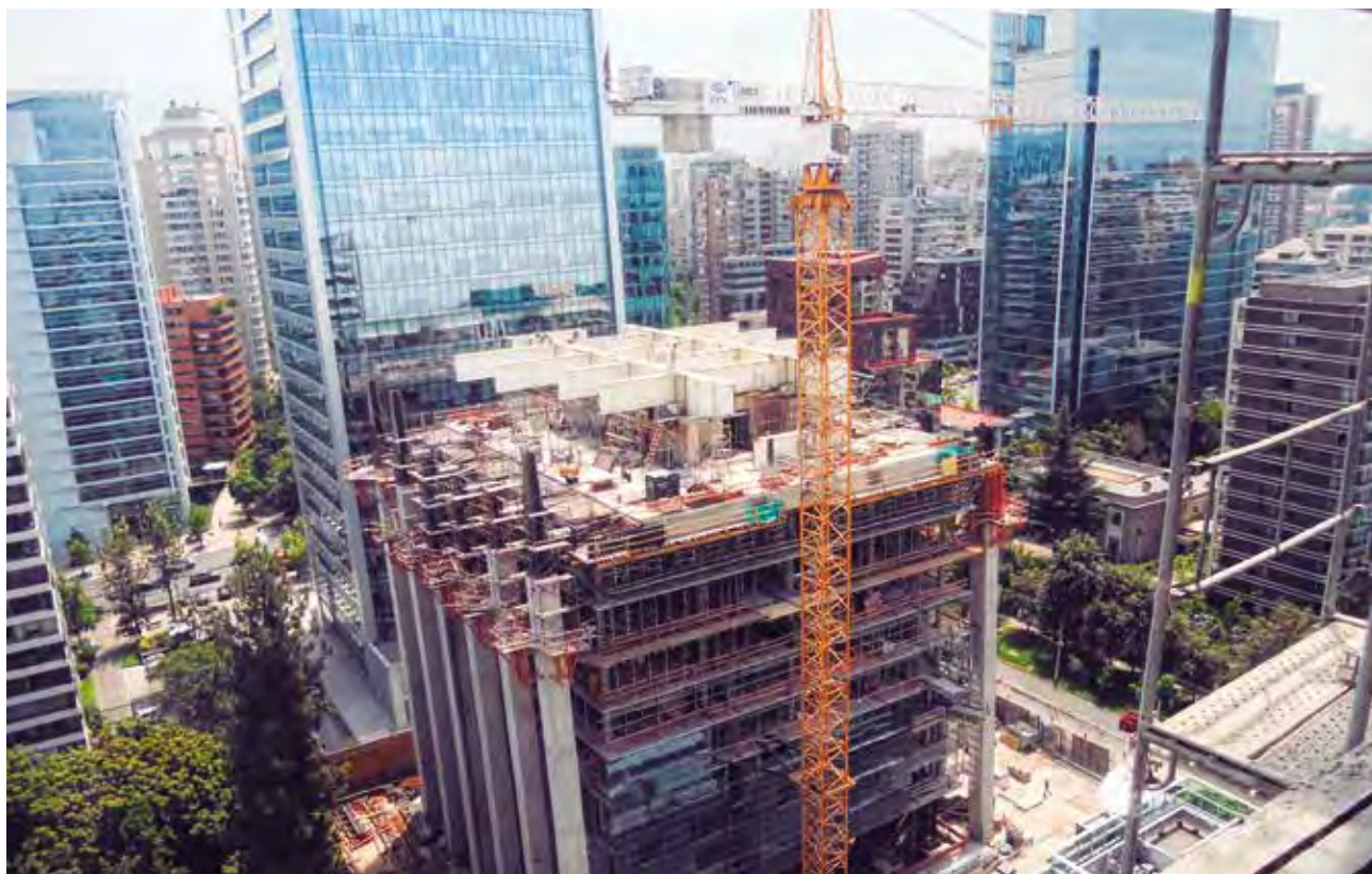
LOSAS POSTENSADAS Y COLUMNAS POSTENSADAS EDIFICIO ALCÁNTARA 99, SANTIAGO – CHILE
