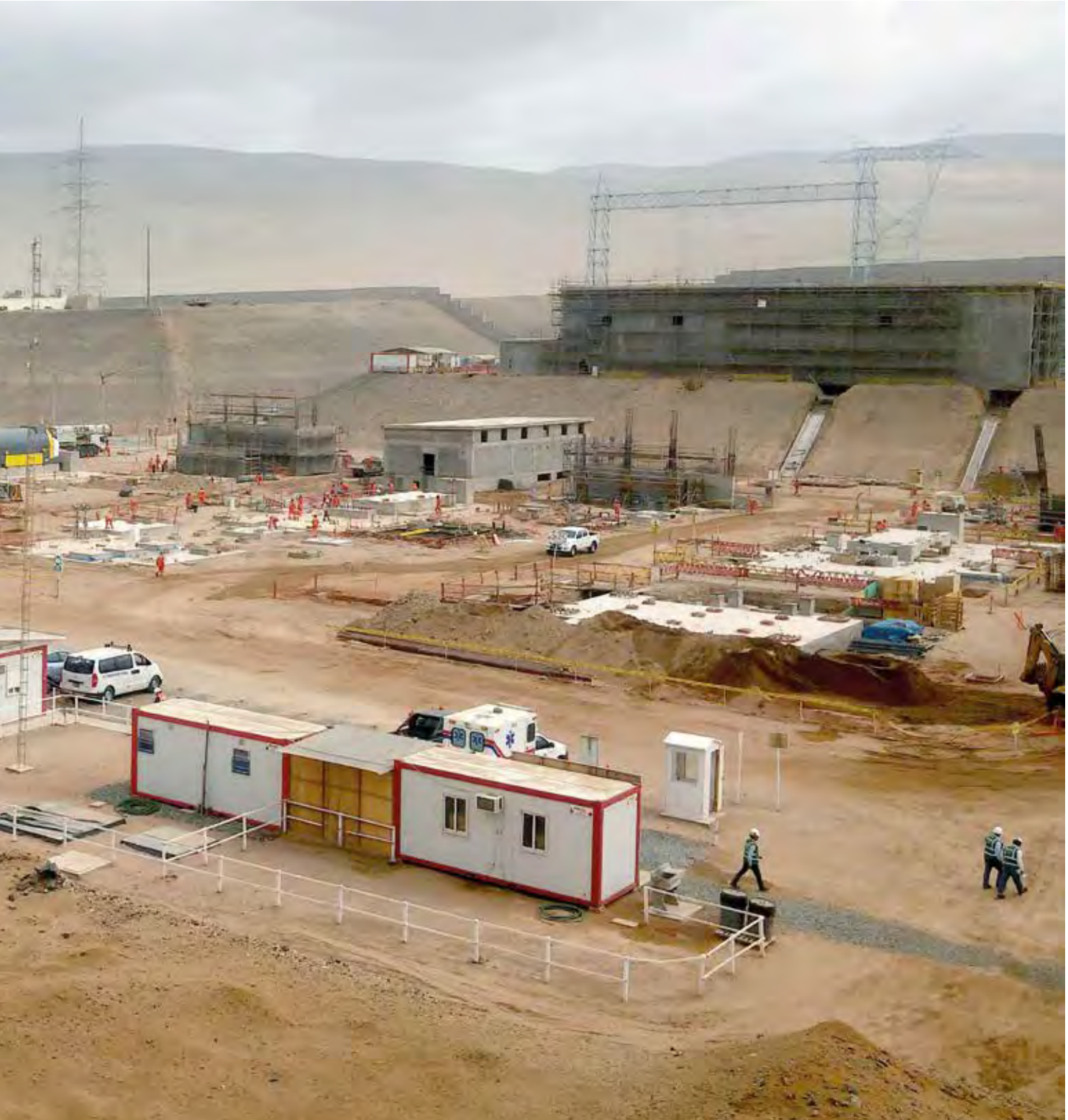
MONTAJE ELECTROMECAÁNICO Y BOP NODO ENERGETICO PLANTA ILO, PROVINCIA DE ILO – PERÚ
