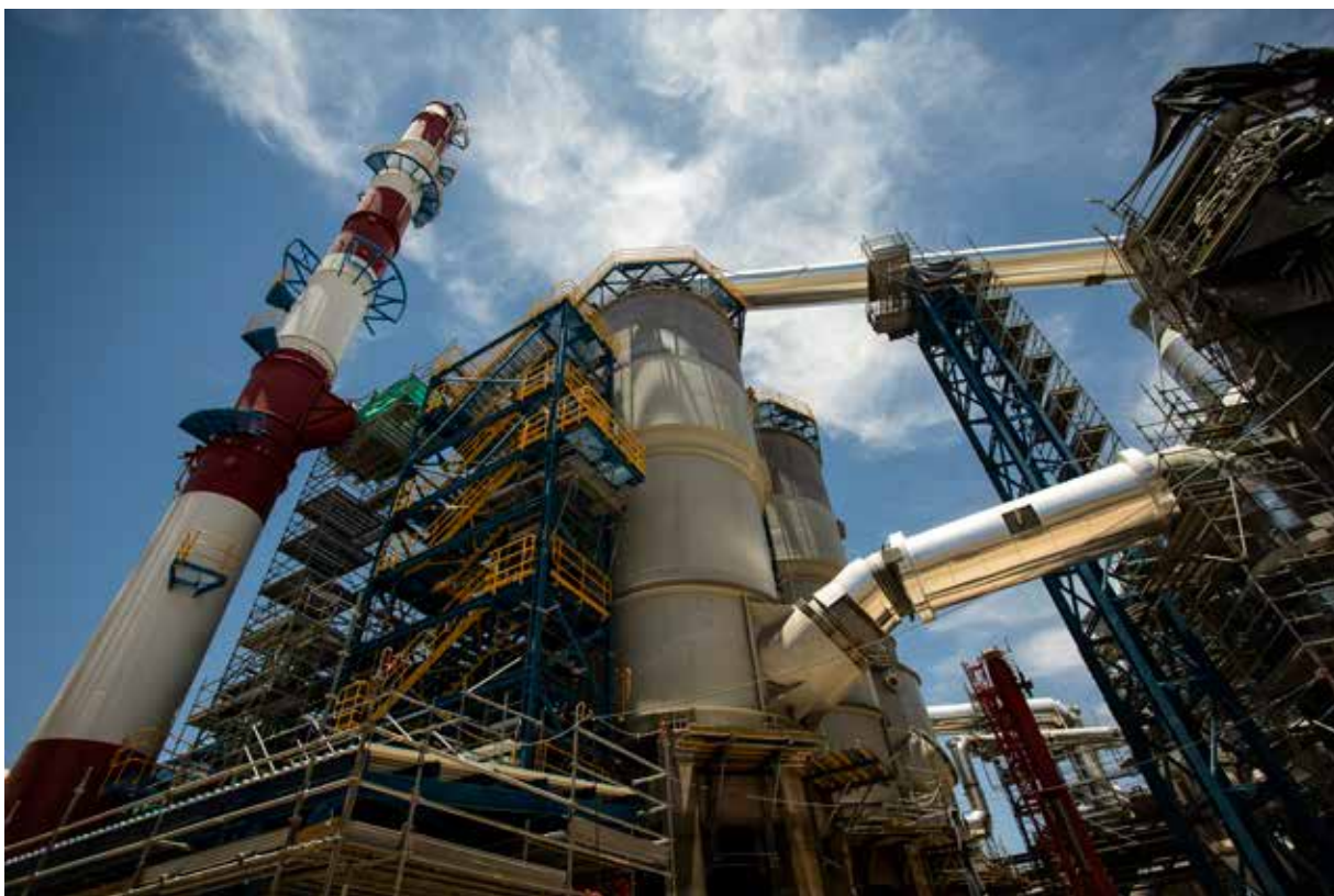
Obras Civiles y Montajes Electromecánico Plantas Ácido 3 y 4 Chuiqcamata, Codelco., Calama – Chile
