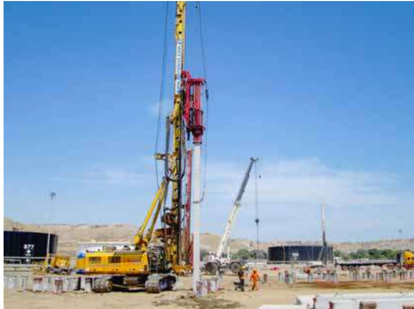
Pilotes en proyecto refinería Talara, Talara – Perú
