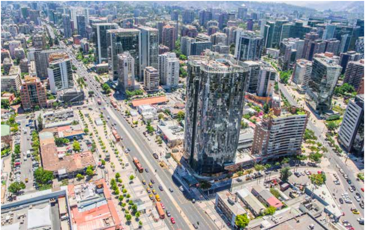
Edificio Apoquindo 5858, Santiago – Chile
