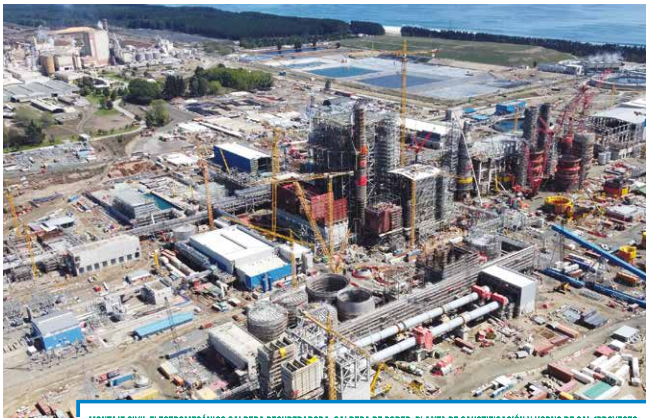
MONTAJE CIVIL ELECTROMECÁNICO CALDERA RECUPERADORA, CALDERA DE PODER, PLANTA DE CAUSTIFICACIÓN Y HORNO DE CAL (PROYECTO MAPA) - CELULOSA ARAUCO Y CONSTITUCIÓN
