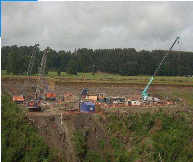
Muro Pantalla Central Hidroeléctrica Rucatayo
