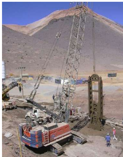
Muro Pantalla Plástica Mina la Coipa
