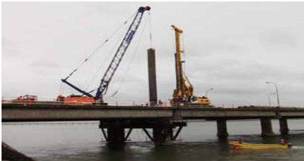
Reparación Puente Juan Pablo II
