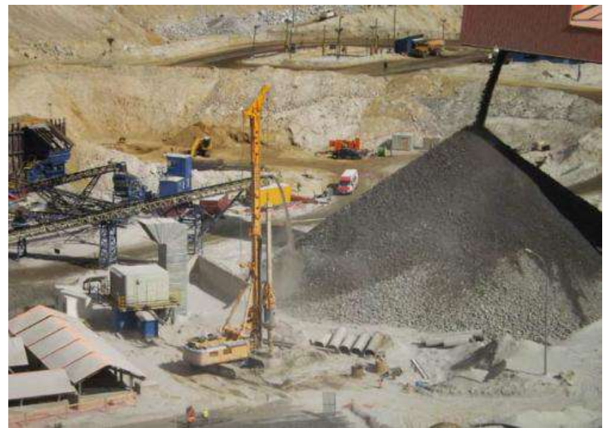
Pilotes pre-excavados Minera Los Pelambres
