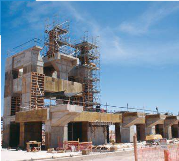
Obras Civiles Minera Spence
