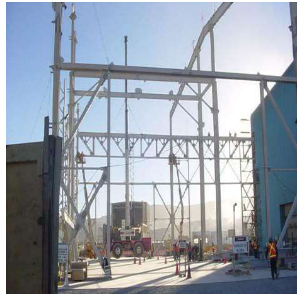
Ampliación Taller de Camiones Minera Escondida
