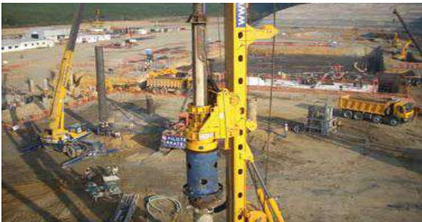
Pilotes pre-excavados Central Termoeléctrica Puerto de Coronel
