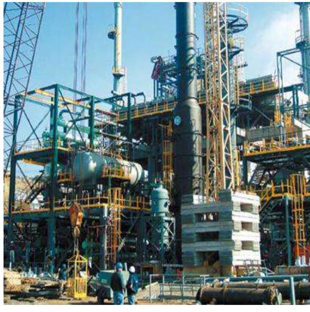
Refinería de Petróleo Concón
