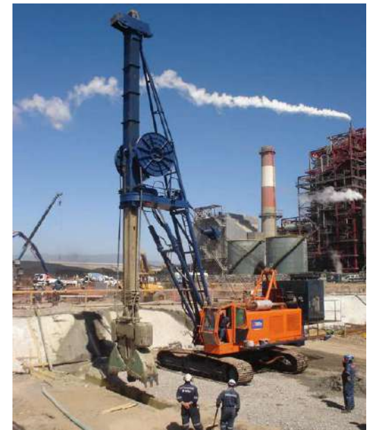
Muro Pantalla Central Termoeléctrica Ventanas III
