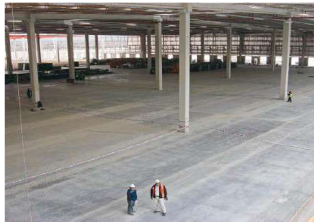
Radier Centro de Distribución Unimarc
