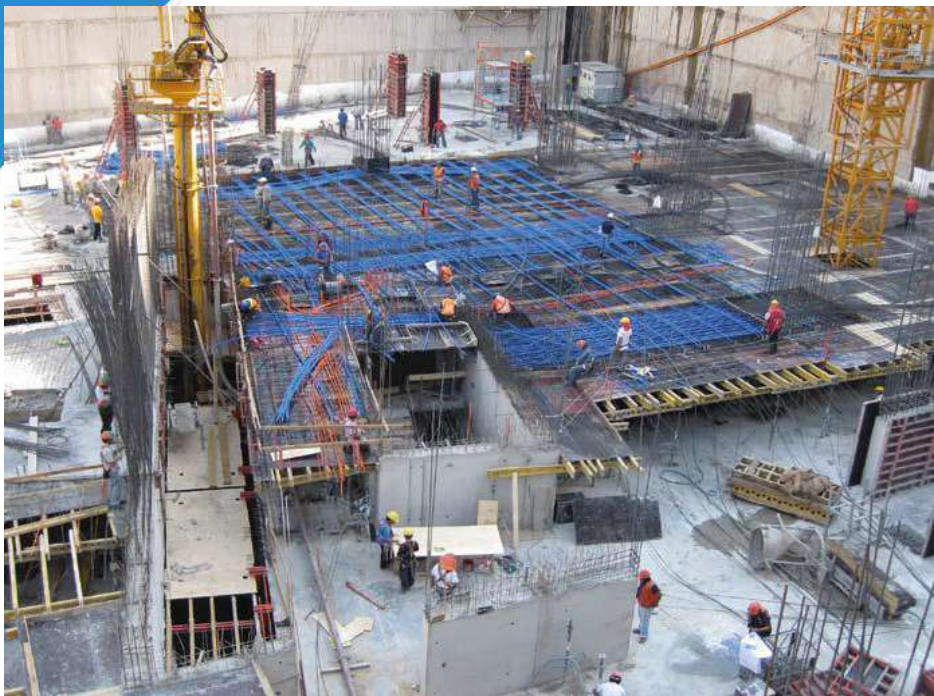
Losa Postensada Edificio de las Artes
