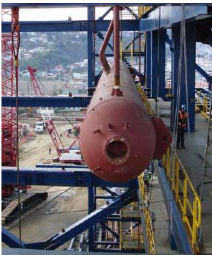
Izaje Caldera Bocamina
