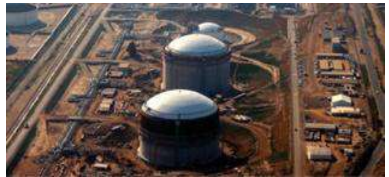
Estanques GNL Quintero
