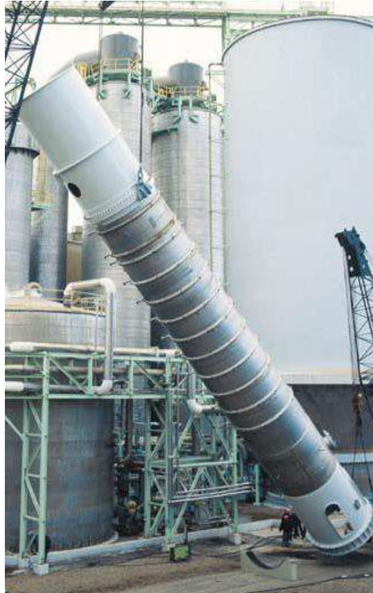
Planta de Celulosa Pacífico, CMPC Celulosa S.A.
