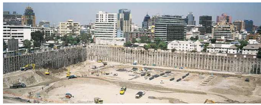
Anclajes Postensados Mall Costanera Center
