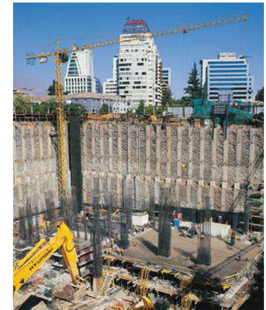
Anclajes postensados Edificio Isidora 3000
