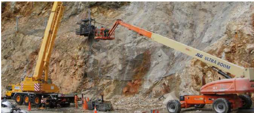
Anclajes Pasivos en Roca, Paso Internacional Pehuenche
