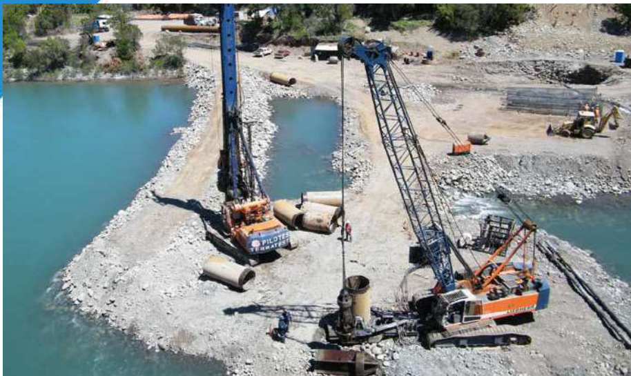
Pilote pre-excavados Puente San Fabián
