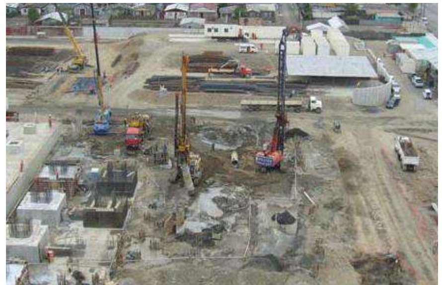
Pilotes pre-excavados Central Termoeléctrica Bocamina II
