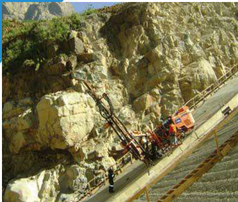
Inyecciones de impermeabilización en roca, Embalse Ancho
