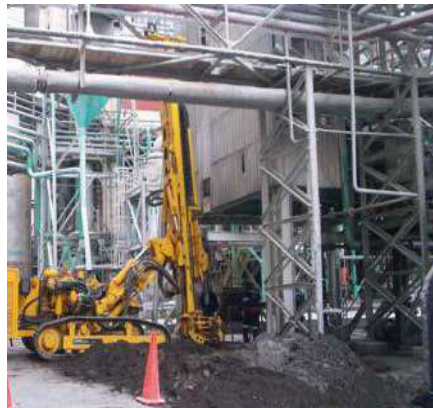
Micropilotes Autoperforantes, Planta CMPC Laja
