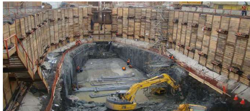
Muro Berlines y Pantalla Plástica CWS Pimp It EN Central Termoeléctrica Puerto Coronel
