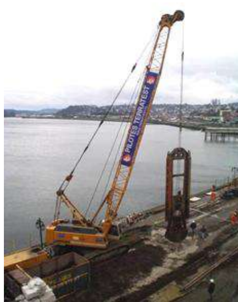
Muro Pantalla Paso Inferior Palcaví, Concepción
