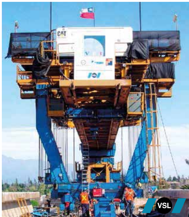
Viaducto Línea 4 Metro de Santiago Santiago - Chile
