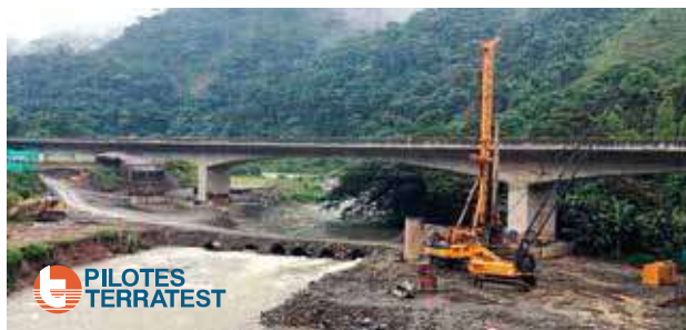
Pilotes Viaducto Carretera Buga Buenaventura Colombia
