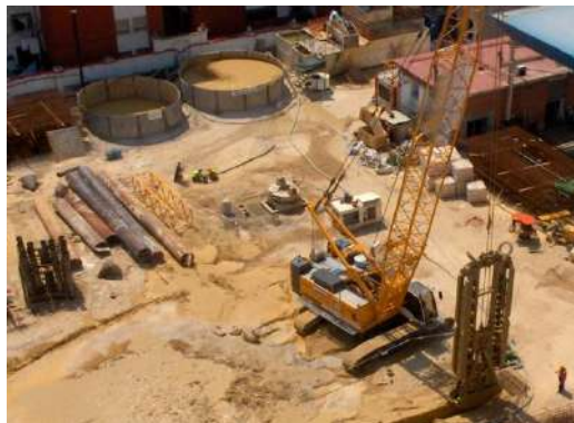
Pantallas y Pilotes de Metro de Lima, Perú
