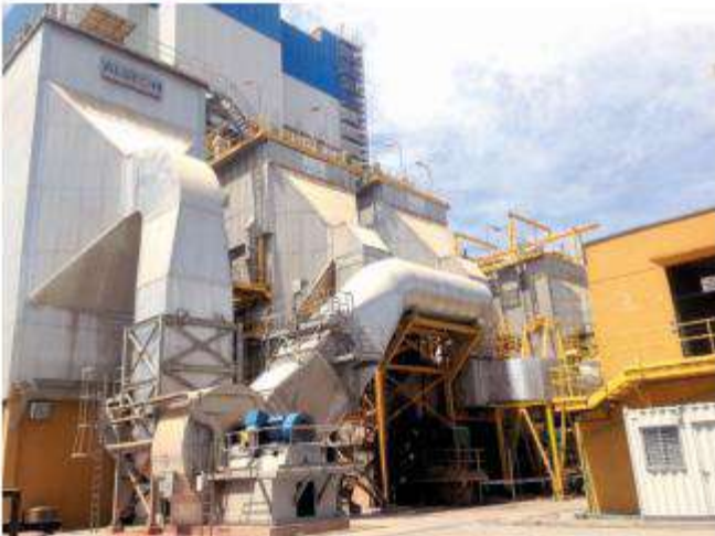
MONTAJE CIVIL-ELECTROMECÁNICO UPGRADE CALDERA RECUPERADORA, ARAUCO CONSTITUCIÓN - CHILE
