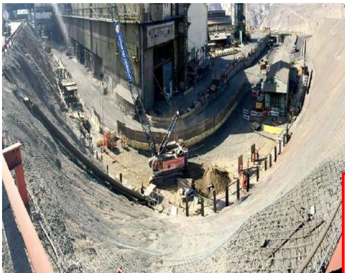
Obras civiles ampliación nave convertidores de Codelco El Teniente.
