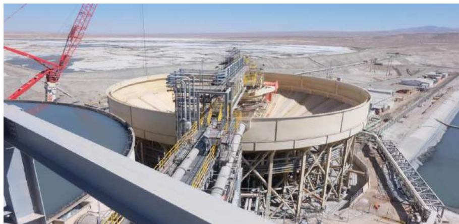
Montaje electromecánico Espesador de Pasta en Mina Centinela, Antofagasta Minerals
