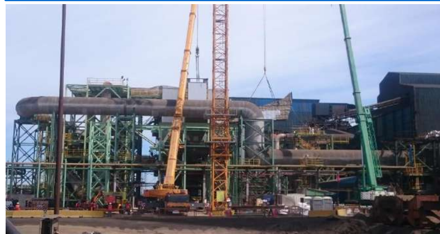
Implementación Sistema captación gases secundarios CODELCO Ventanas
