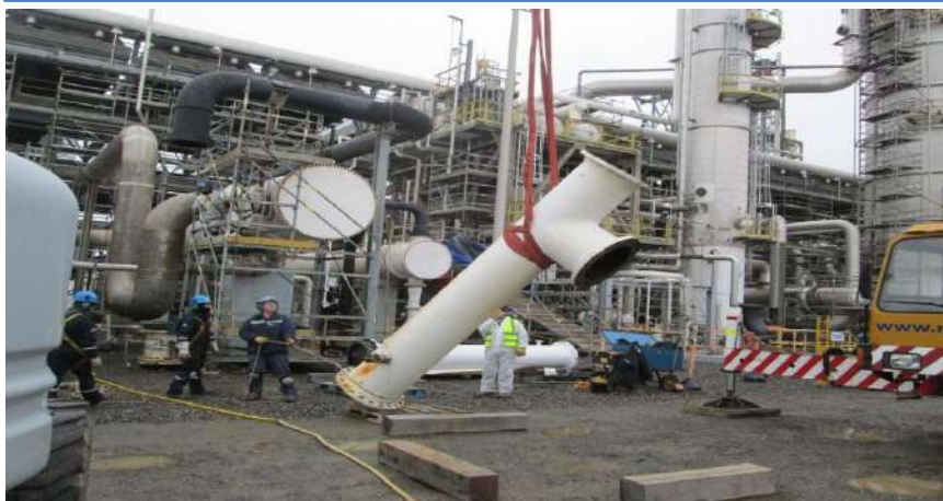
Mantenimiento industrial, paro programado Planta Methanex, Punta Arenas
