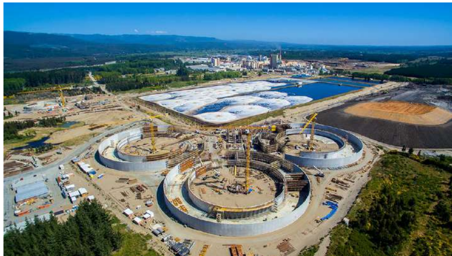
Montaje civil electromecánico Planta Tratamiento de Efluentes, Celulosa Arauco y Constitución
