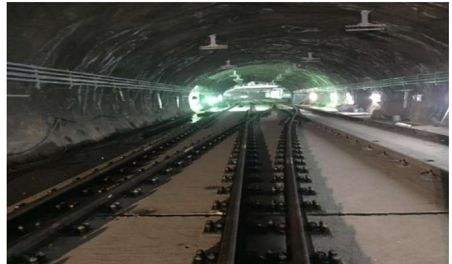
Túnel Interestación Los Leones. Metro de Santiago
