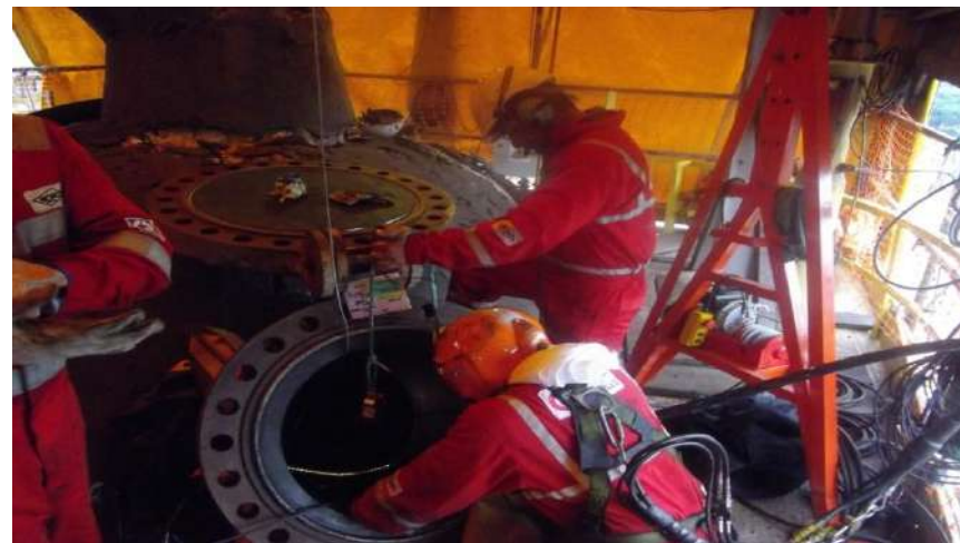
Catalizador y decoking, Fafen, cambio catalizador, Paraná-Brasil
