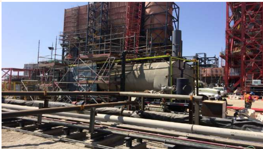
Agua alta presión, servicio de lavado e inspección en Refinería Aconcagua Con-Con
