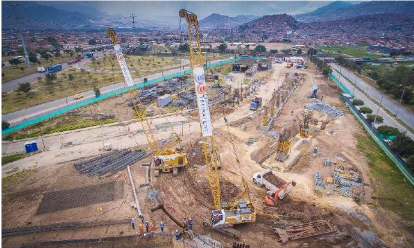
Cimentación Transmicable. Estación El Tunal, Bogotá, Colombia
