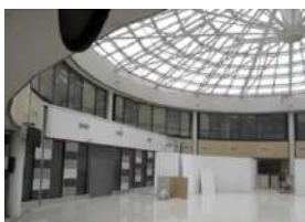
Obras Aeropuerto Arturo Merino Benítez
