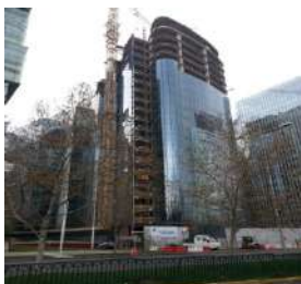
Edificio Nueva Las Condes 7
