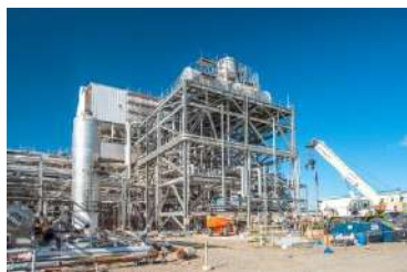
Desmontaje tren N°3 Planta Metanol
