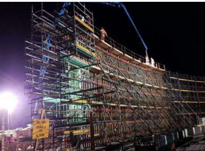
Planta tratamientos Efluentes Arauco. Hormigonado de muros.
