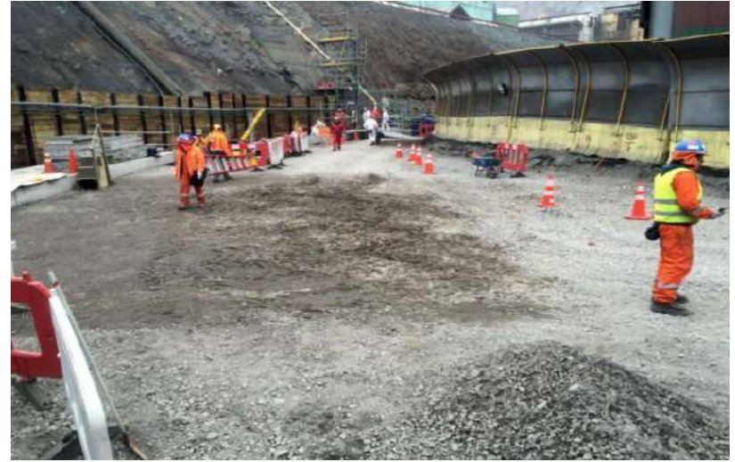
Ampliación nave convertidores Codelco Fundición Caletones
