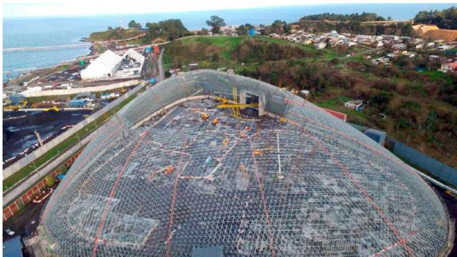
Obras civiles y montaje Domo geodésico techado de canchas de carbón central Bocamina.
