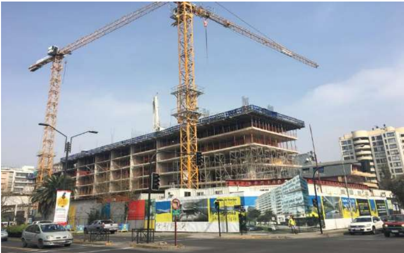
Edificio Los Leones. Santiago, Chile.
