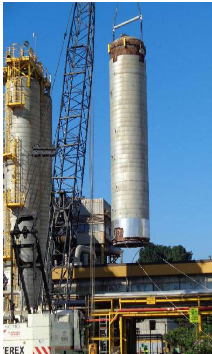
Upgrade Caldera recuperadora Arauco
