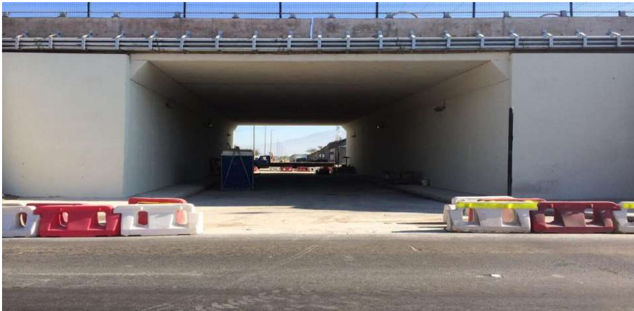
Paso inferior Los Maitenes Sur, Santiago.
