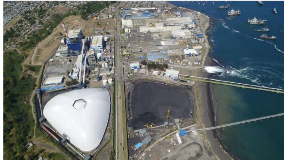
Obras civiles y montaje Domo geodésico para techado de canchas de carbón sur de Central Bocamina, Enel.
