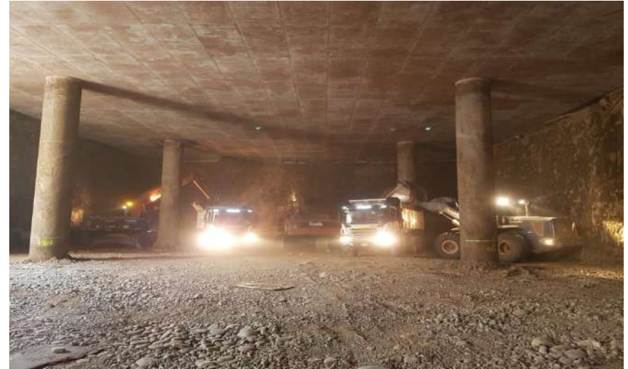
Muros pantalla y Pilotes Metro de Lima (Línea 2), Lima, Perú.
