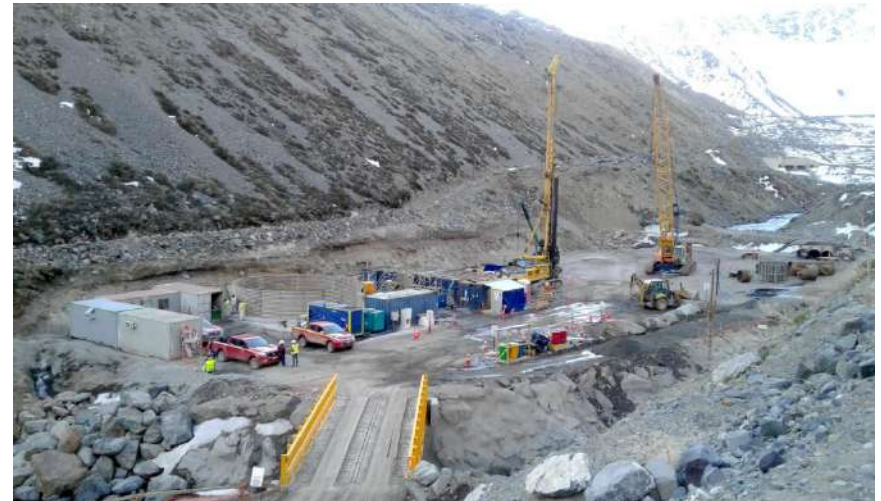
Pilotes Pre-Excavados de fundación y de impermeabilización, Bocatoma el Yeso.
