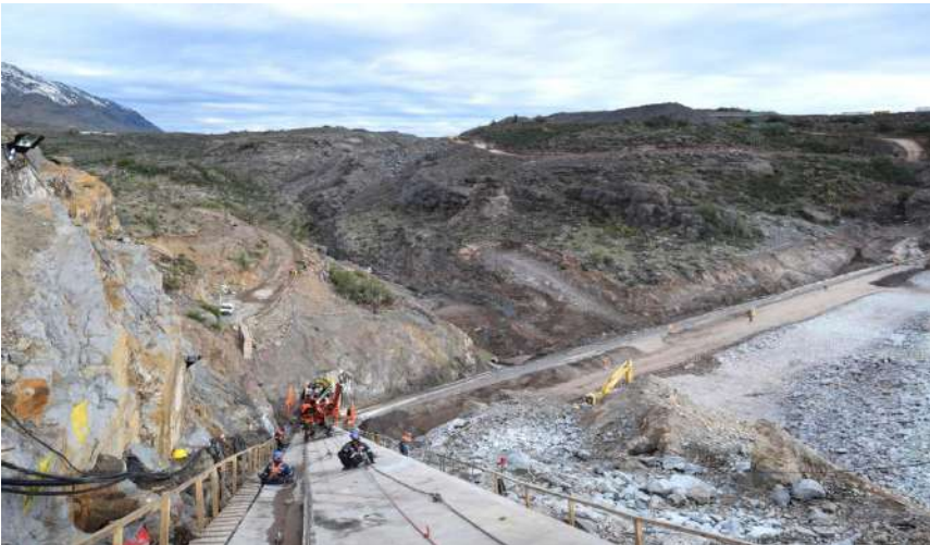
Inyecciones de consolidación e impermeabilización, Embalse Valle Hermoso.
