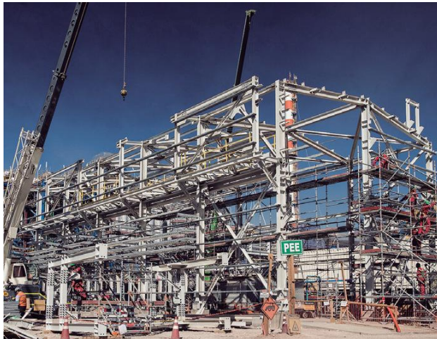
OO.CC. Y Montaje Electromecánico Ministro Hales
