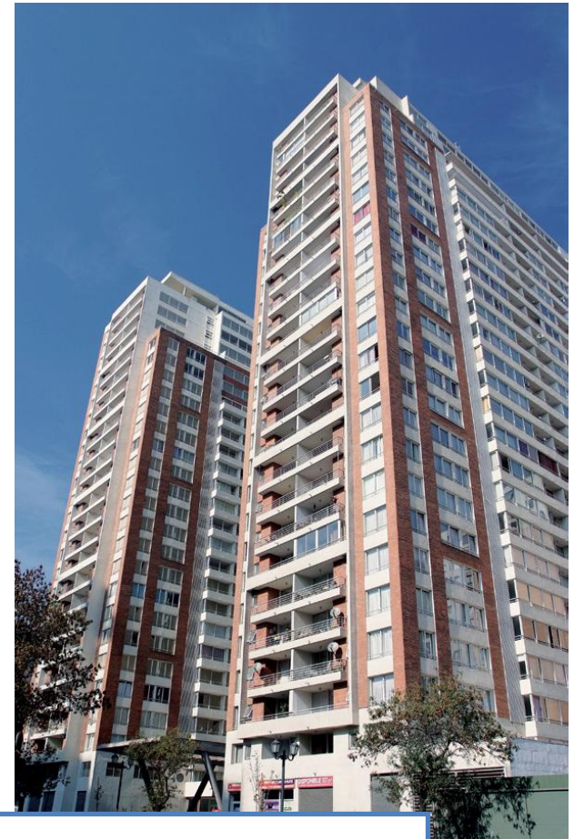
Edificios Alto Plaza Bulnes - Santiago
