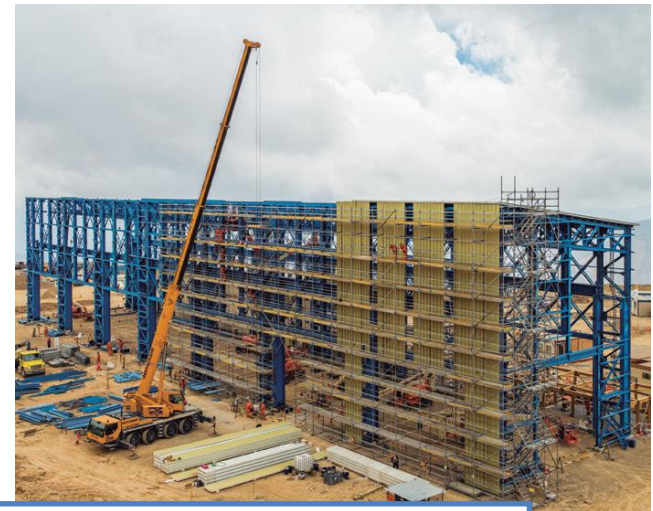
OO.CC. Y Montaje Electromecánico El Teniente
