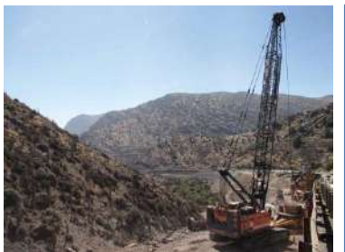
Pilotes Viaducto Las Chilcas, Ruta 5 Norte
