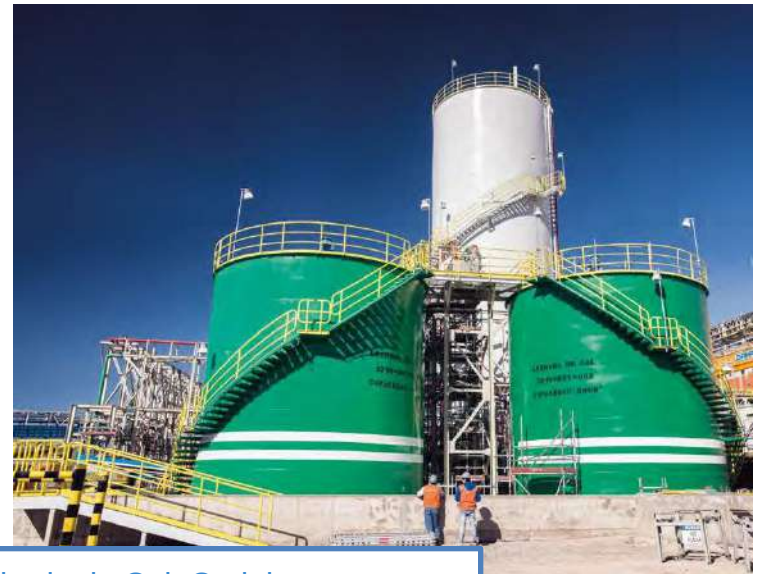
Planta Lechada de Cal, Codelco Ministro Hales, Calama - Chile
