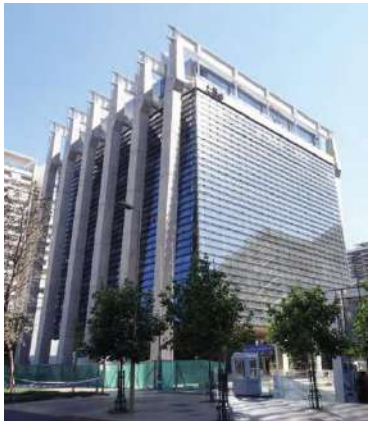
Losa Postensada y Columnas Postensadas. Edificio Alcántara 99 - Santiago
