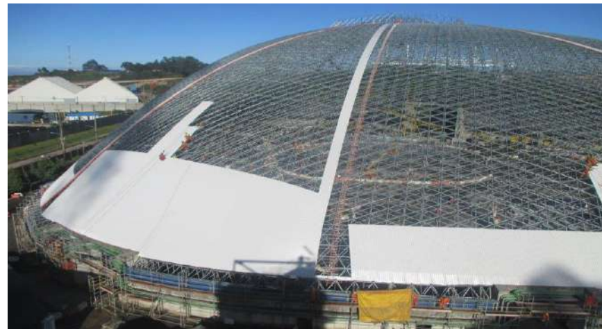
Obras civiles y montaje Domo geodésico para techo de canchas de carbón de Central Bocamina.
