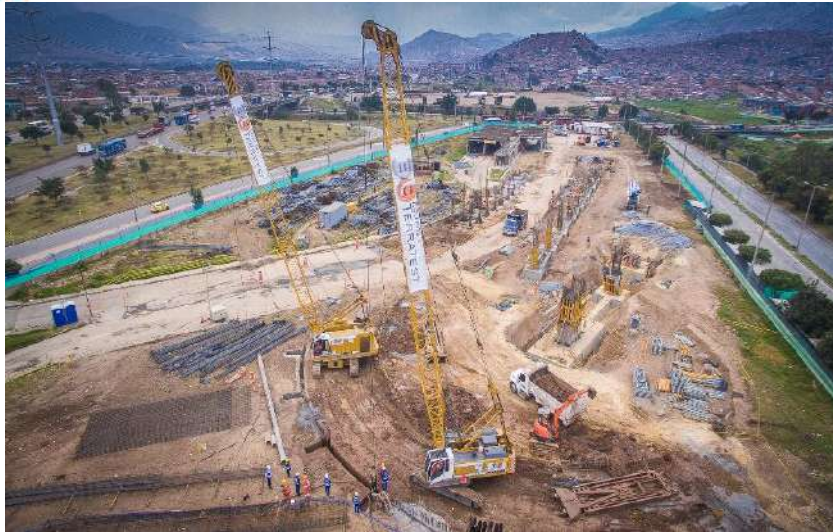
Cimentaciones TransMiCable - Estación El Tunal. Bogotá, Colombia.
