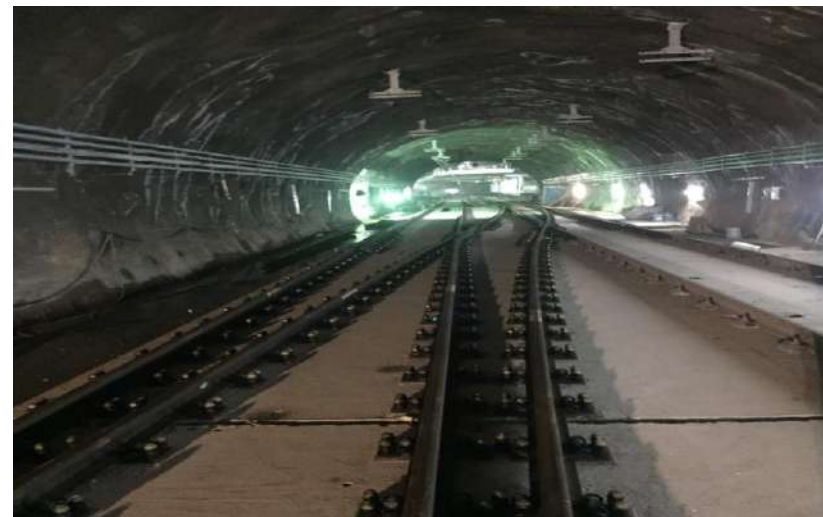
Túnel Interestación Los Leones. Metro de Santiago.
