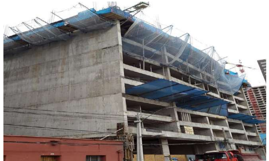
Edificio Conde del Maule. Santiago, Chile.
