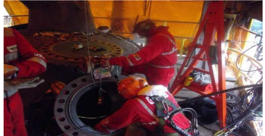
Cambio de catalizador Reactores Shift, Petrobras Fafen, Araucaria-Brasil
