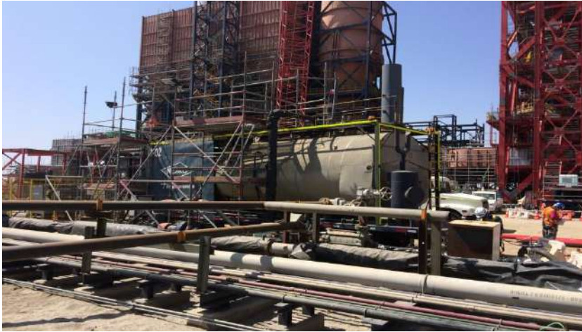
Limpieza química calderas Proyecto Cochrane Mejillones.
