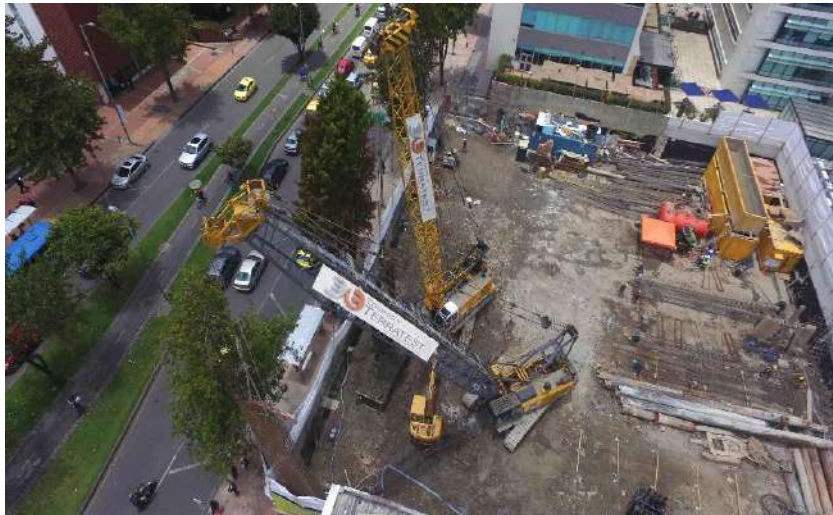
Pilotes Pre-excavados y pantallas de Mall 100. Bogotá, Colombia.
