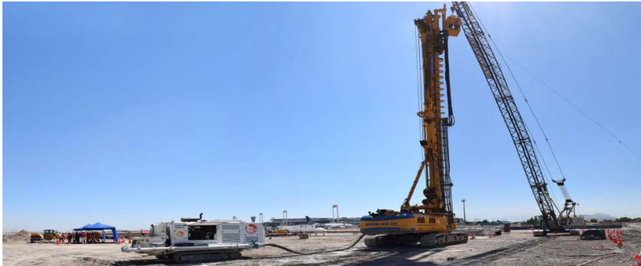
Pilotes CFA, Bajo lodos y ensayos de carga en ampliación Aeropuerto Arturo Merino Benítez
