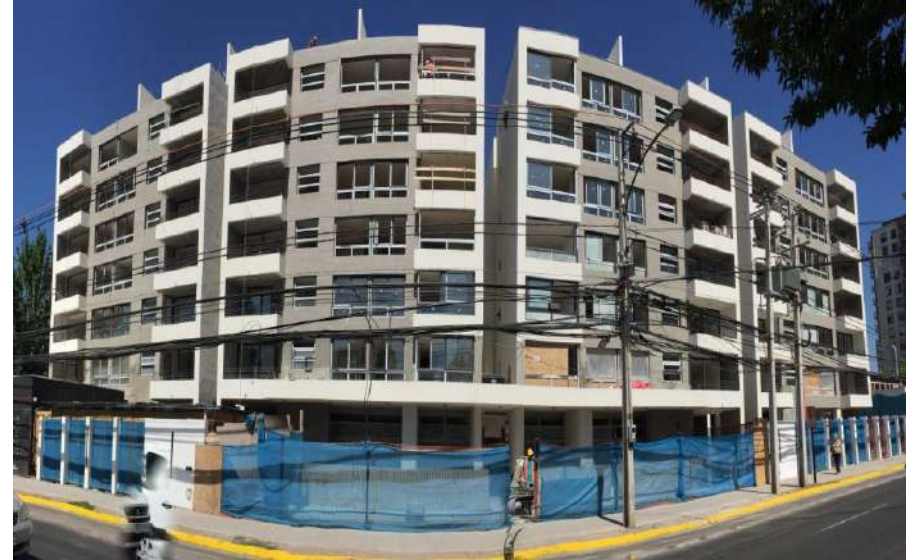
Edificio Sucre. Santiago.
