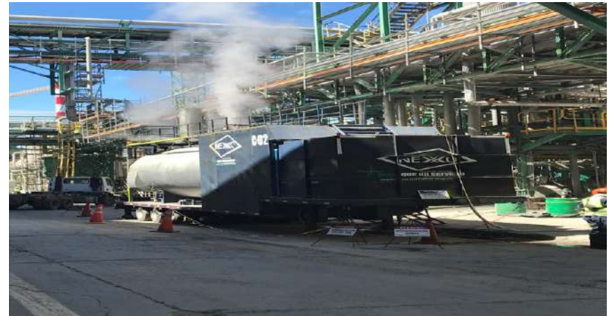
CMPC, Planta Laja, Limpieza química e inertización de circuitos.
