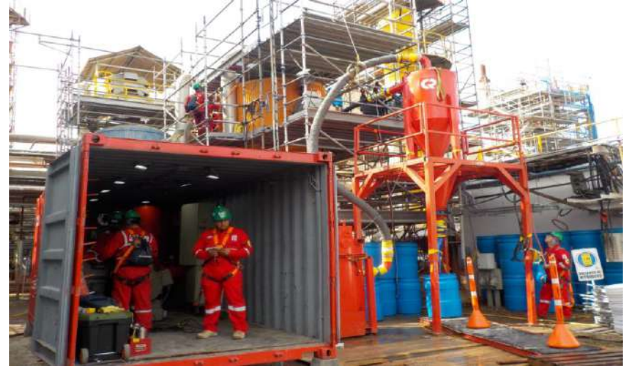
Yara Colombia S.A Servicio de cambio de catalizador en parada de planta de amoniaco.
