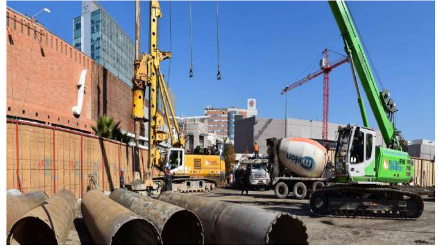
Entibación con pilotes y anclajes Edificio Cerro El Plomo- Alonso de Cordova. Santiago, Chile.
