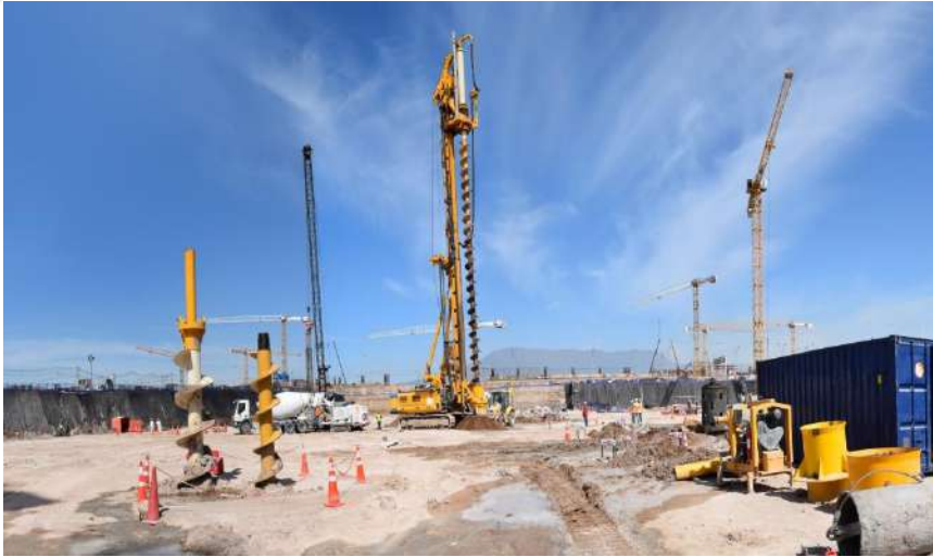
Pilotes CFA, bajo lodos y ensayos de carga en ampliación Aeropuerto Arturo Merino Benítez, Santiago.
