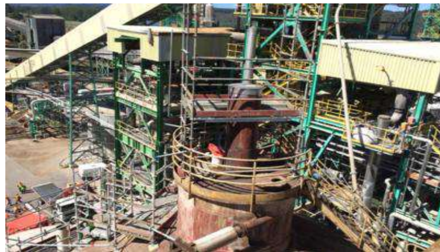
Montaje electromecánico equipos DNCG, torres de enfriamiento y salas eléctricas - CMPC Laja, Chile.
