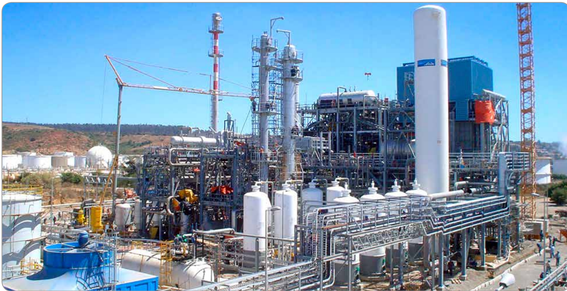
Obras Civiles y montaje electromecánico Planta Hidrógeno
