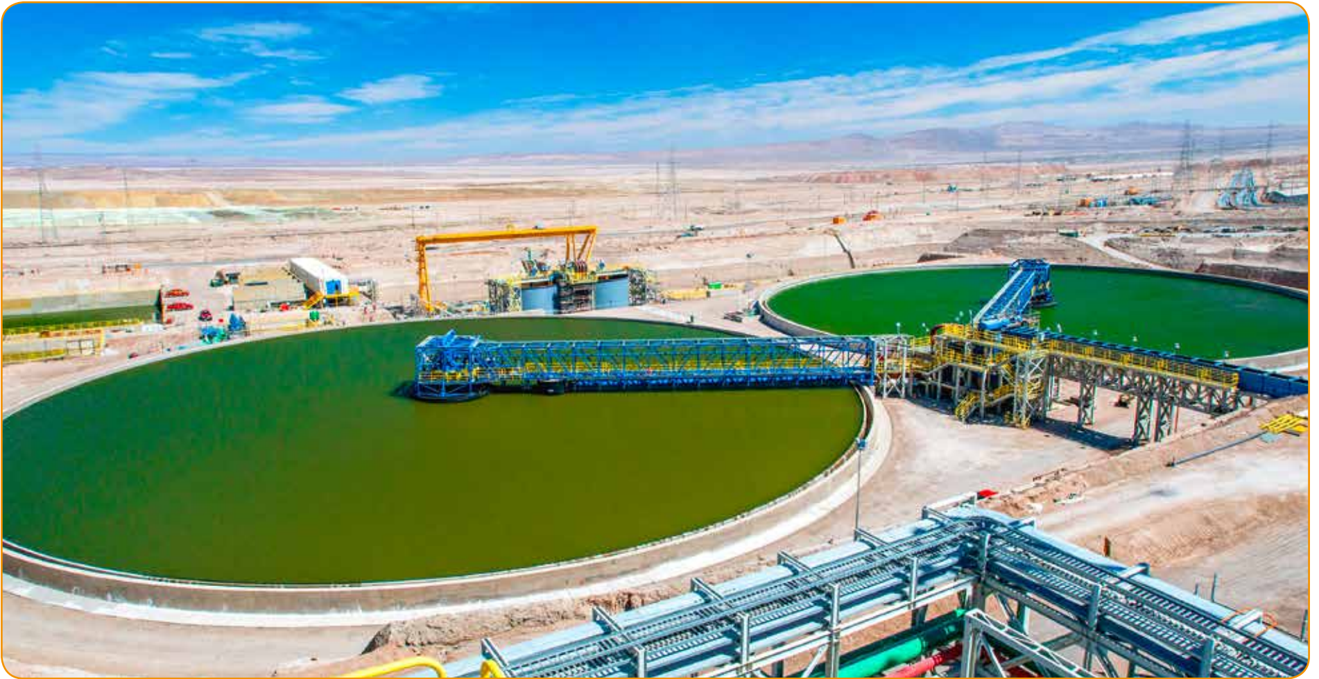
Construcción espesadores de relaves, Codelco - Ministro Hales
