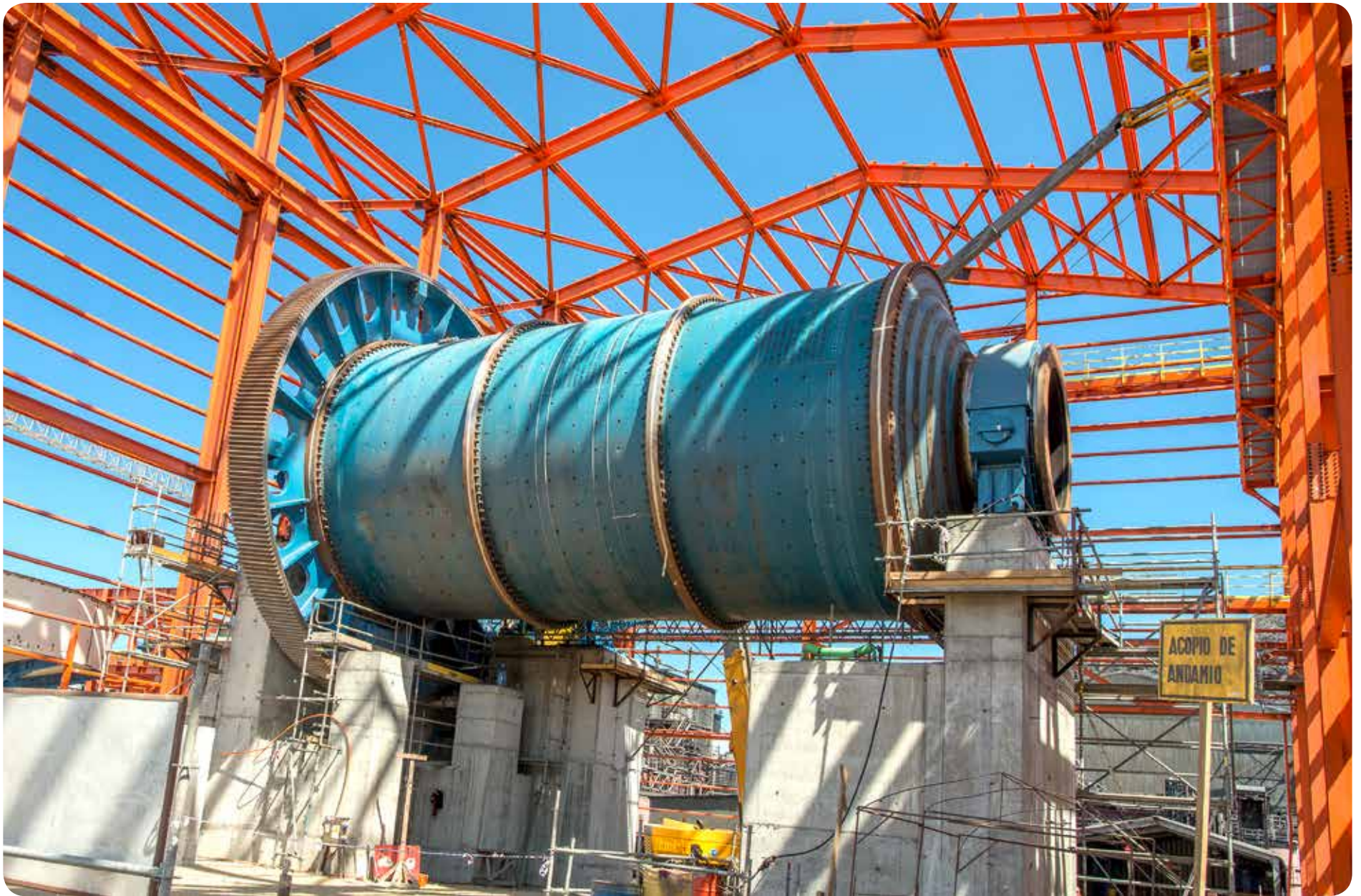
Montaje molino de bolas y edificio de molienda Planta Pellets, Huasco
