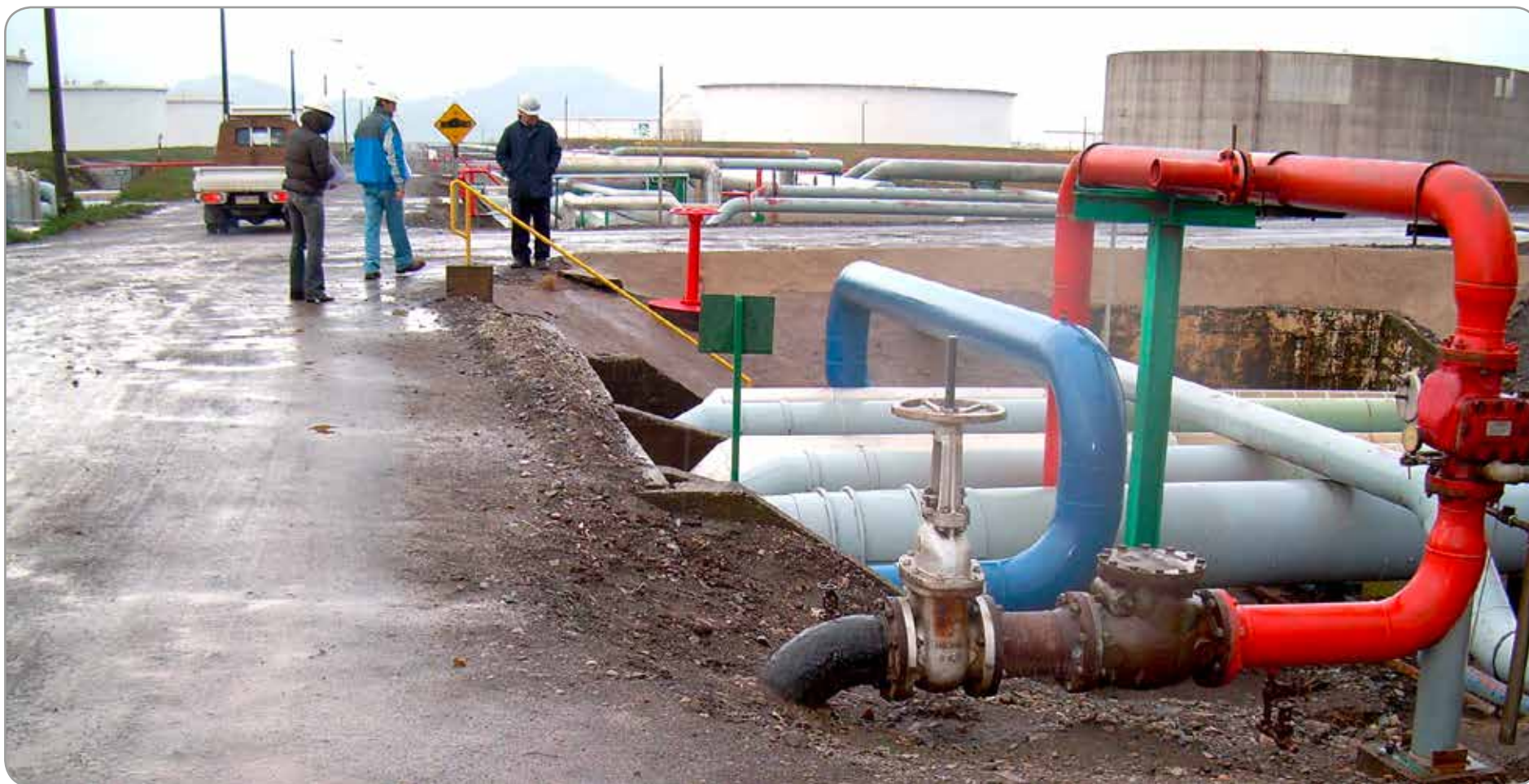
Obras Civiles y montaje mecánico de cañerías, soprtes, excavaciones y rellenos de la nueva red contra incendio subterránea
