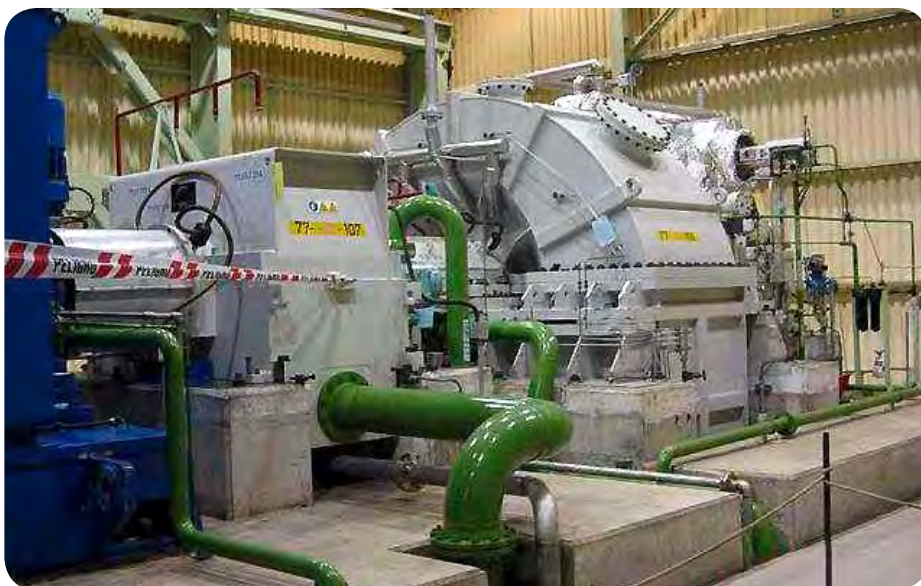
Montaje Turbogenerador 40 MW, CMPC Planta Pacífico
