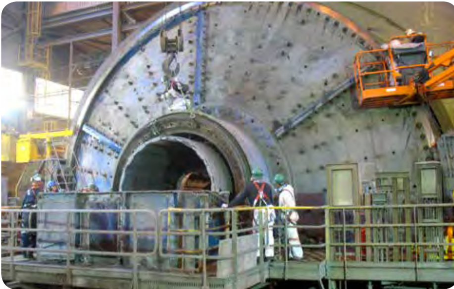
Reparación molino SAG N°1 - Minera Candelaria
