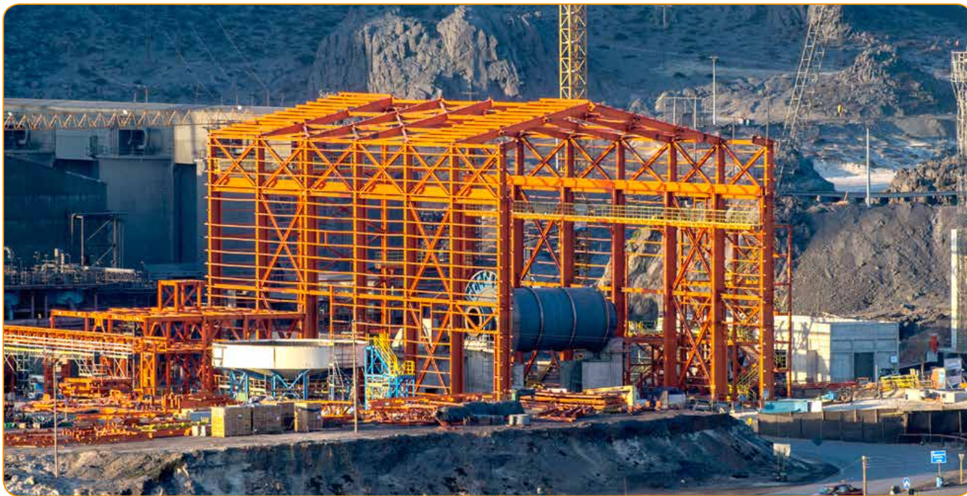
Construcción y montaje de edificio de molienda, molino de bolas, salas eléctricas y espesador de concentrado
