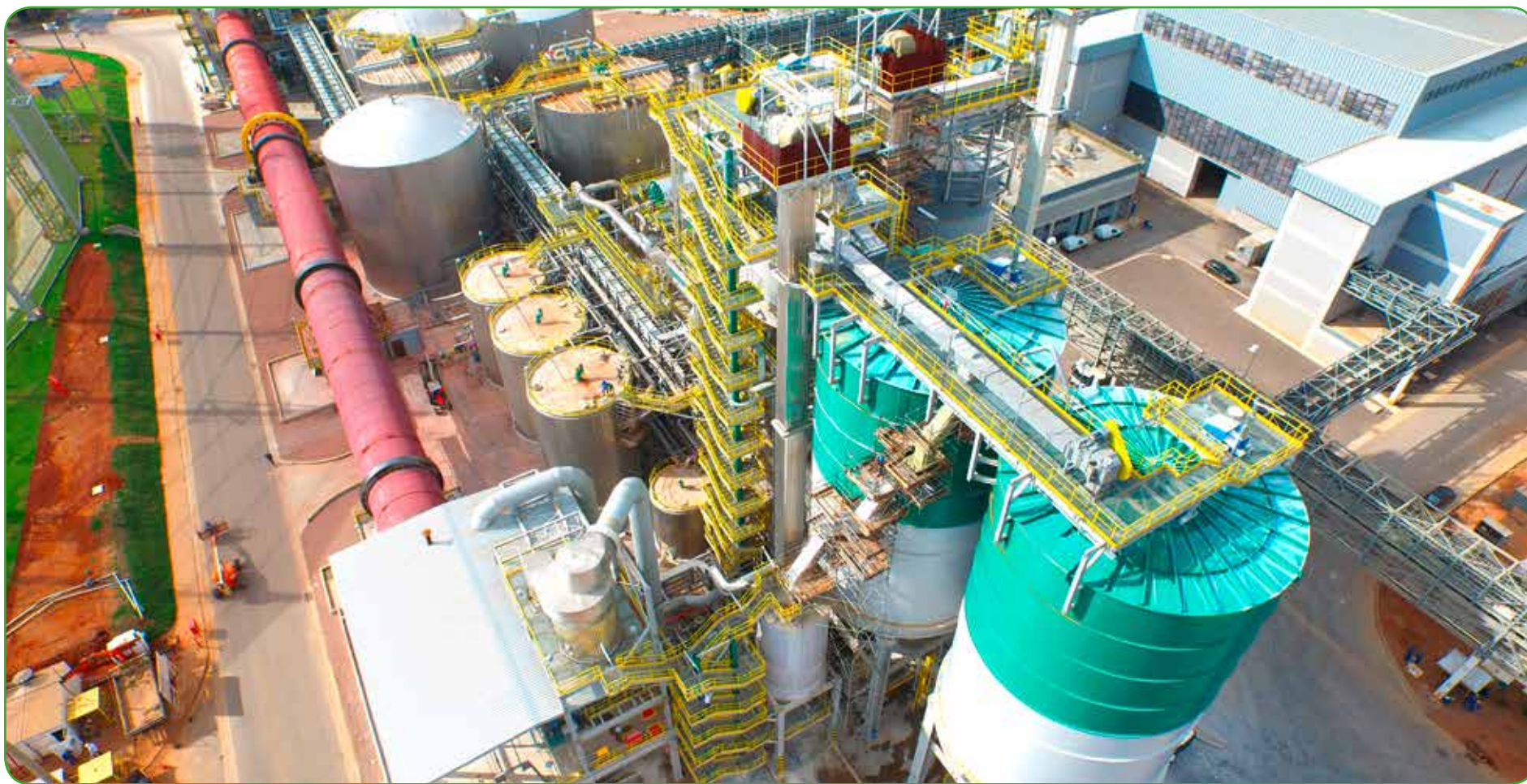
Montaje electromecánico planta Caustificación y Horno de Cal CMPC Guaiba - Brasil
