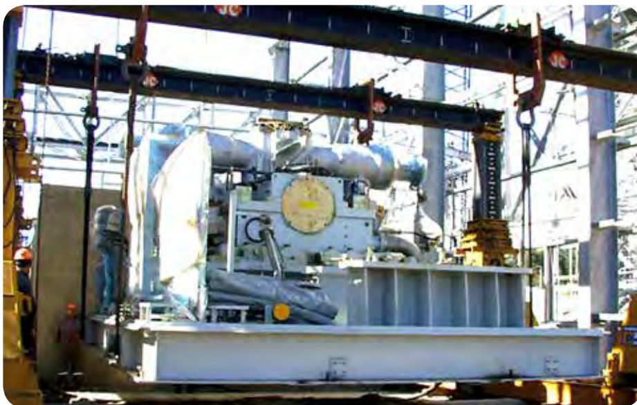
Montaje Turbogenerador Diesel 10 MW, Arauco Planta Itata
