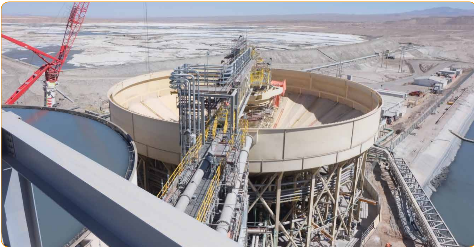
Montaje espesador tipo Deep Cone de 45 mt de diámetro, además de Obras civiles, eléctricas e instrumentación y mecánicas asociadas
