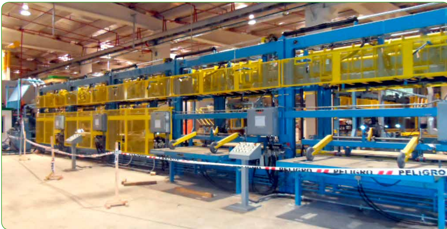
Montaje electromecánico planta terciado, proyecto Fénix, Nueva Aldea
