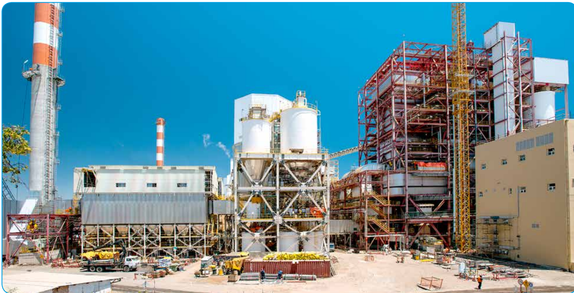
Montaje electromecánico Caldera Unidad 3 y 4, Central Nueva Ventana - Campiche
