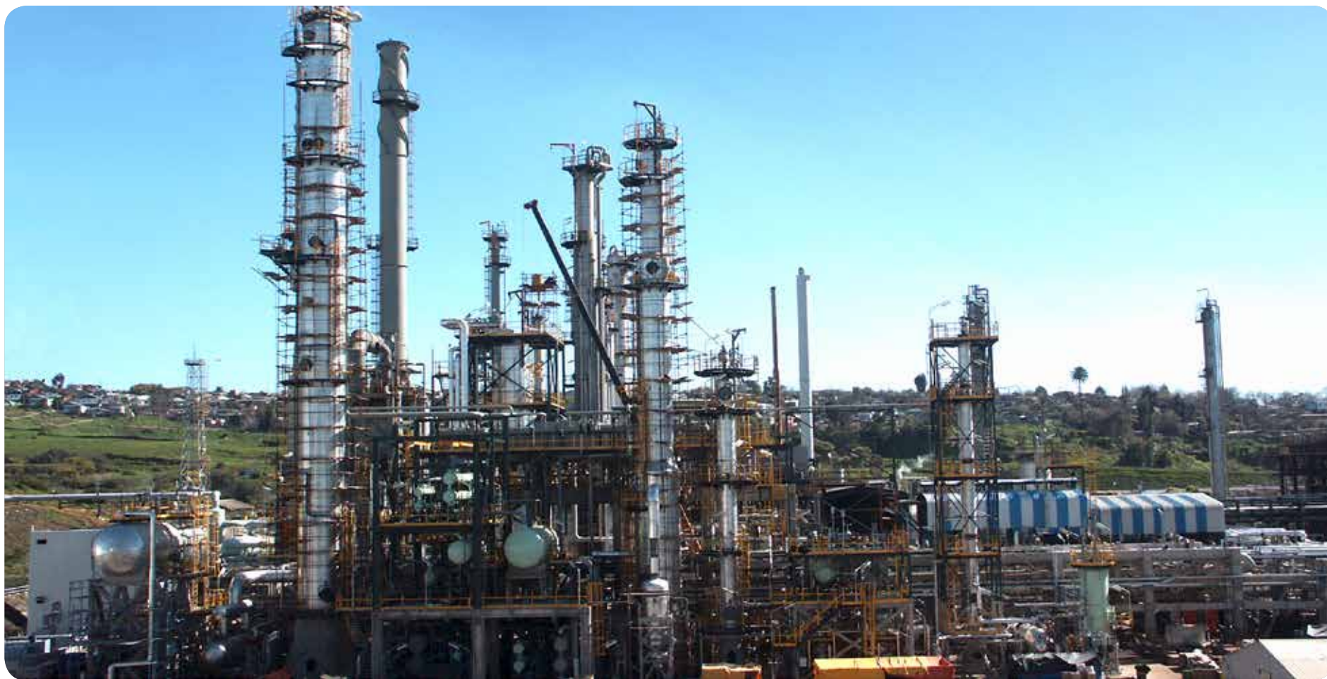
Montaje mecánico, eléctrico e instrumental de la nueva Unidad Desulfurizadora de Gasolina Planta RPC - Concón
