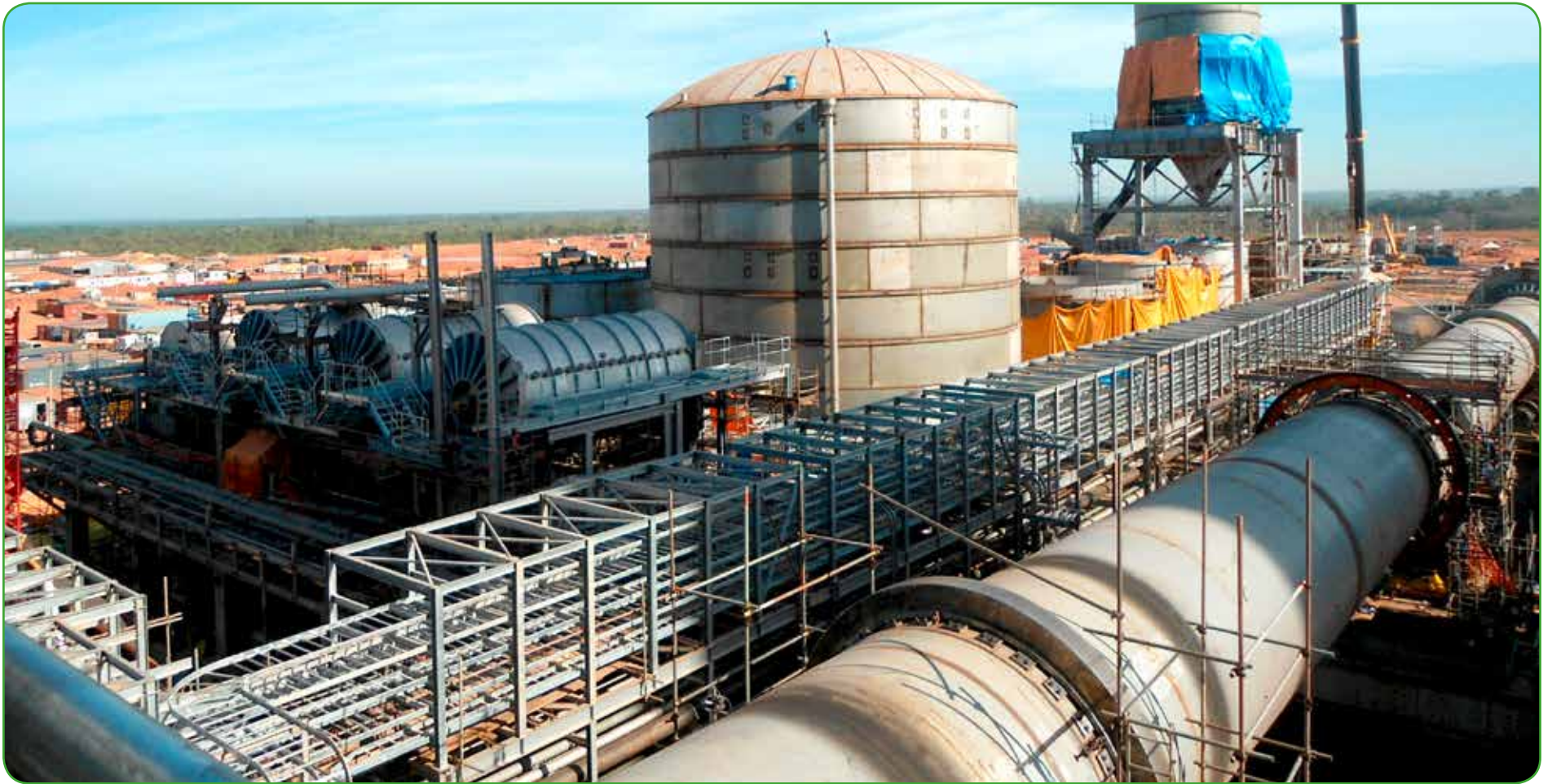
Caustificación, Turbogeneradores, Horno de Cal y Patio de Madera, Planta Suzano - Brasil
