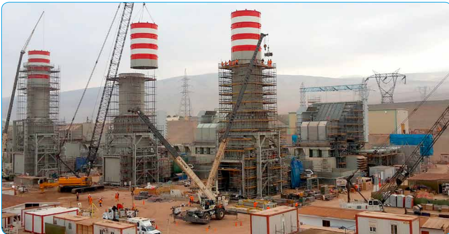
Central termoeléctrica de doble combustible (Gas/Diesel) 600 MW - Montaje mecánico, piping e instrumentación
