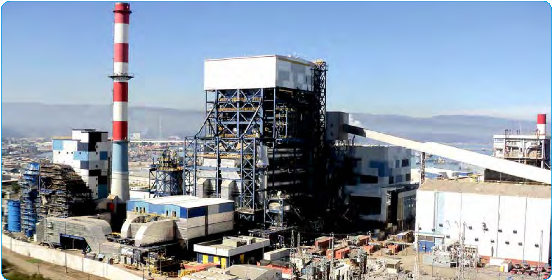
Montaje mecánico Caldera 370 MW Central Cenral Bocamina II - Coronel
