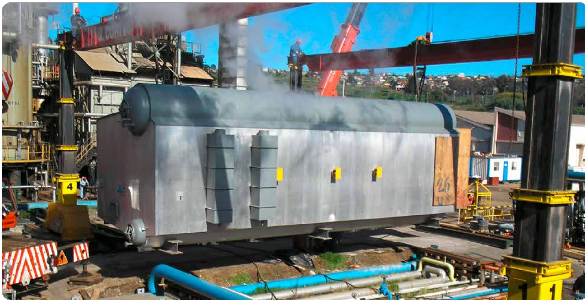
Obras civiles y Montaje Caldera de vapor de 90 ton.
