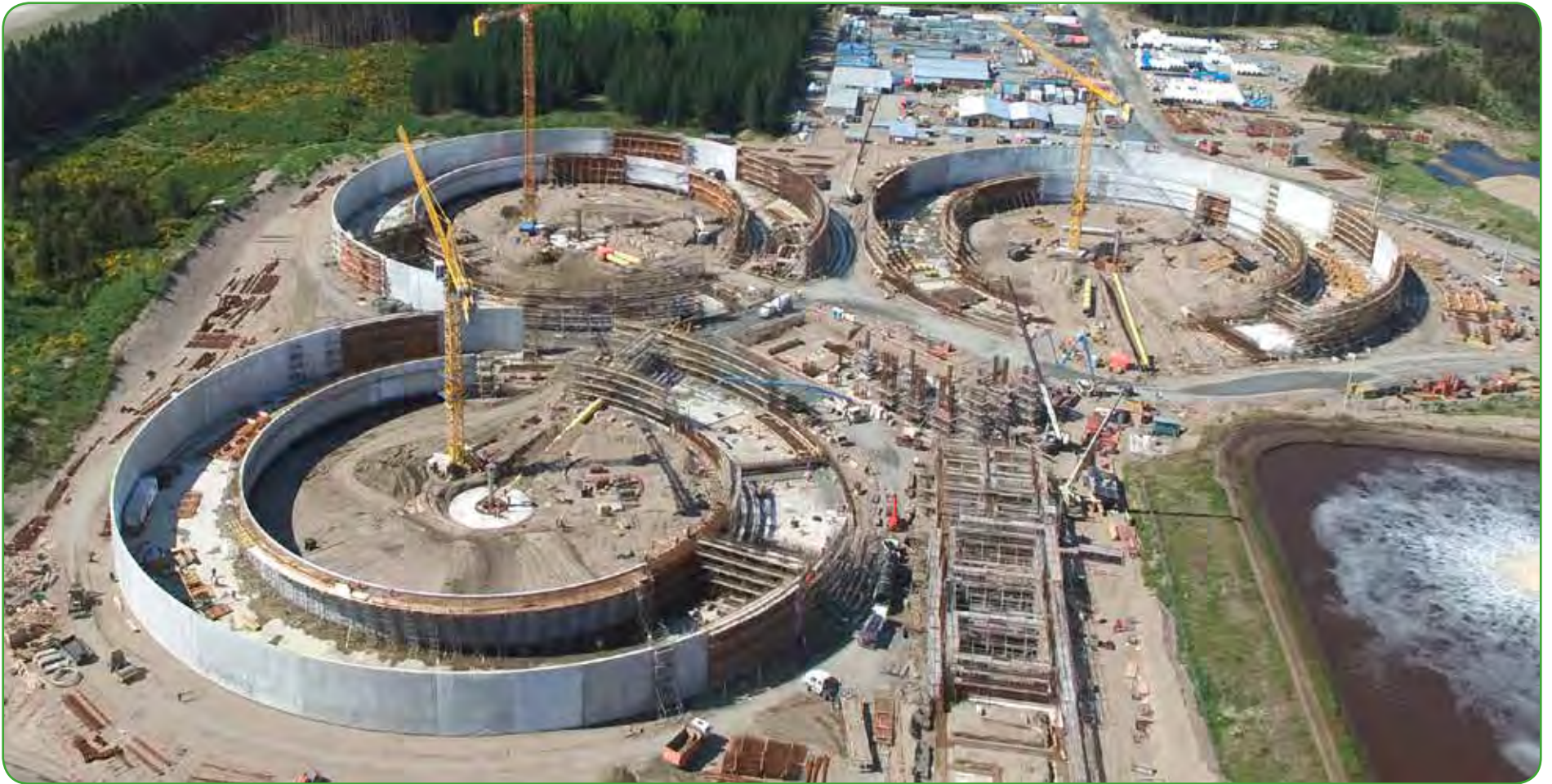
Montaje civil-electromecánico planta Tratamiento de Efluentes, Celulosa Arauco
