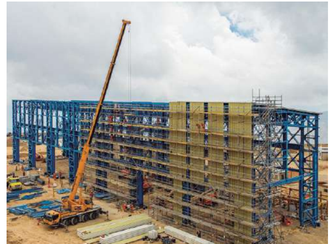
OO.CC. Y Montaje Electromecánico El Teniente
