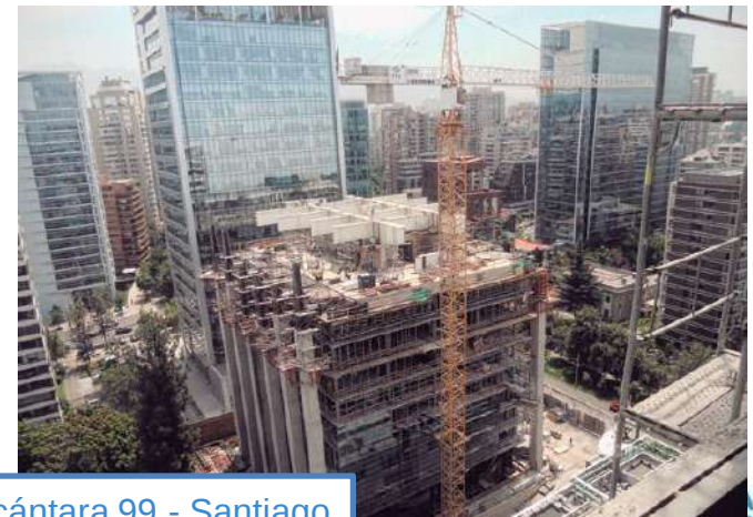
Losa Postensada y Columnas Postensadas. Edificio Alcántara 99 - Santiago
