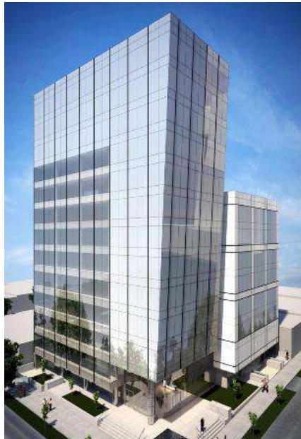
Edificio Eureka, construye sociedad CyJ-EI, participa VSL en las losas postensadas
