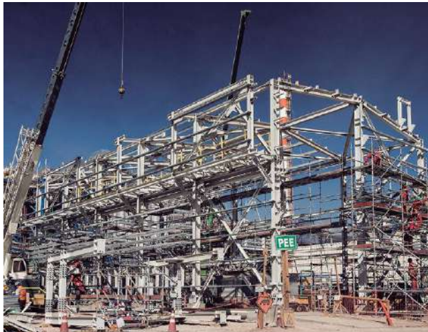
OO.CC. Y Montaje Electromecánico Ministro Hales
