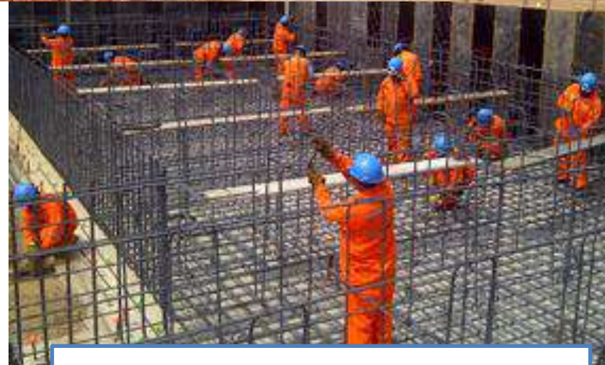
Planta de Poder Siemens, Chilca - Perú
