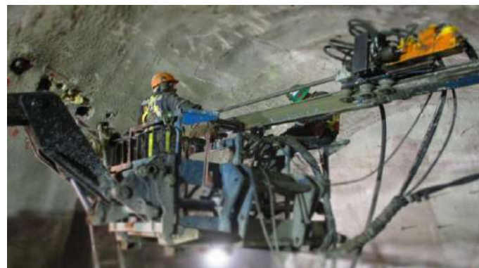
Piques y galerías, tramos 3 y 4 (L6) Metro de Santiago
