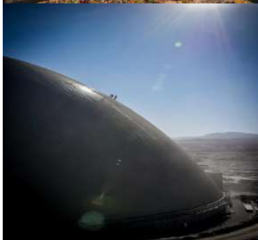
Minera Centinela, Línea de chancado secundario y terciario.
