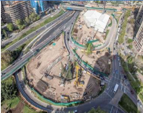
Obras de mejoramiento Costanera Norte.
